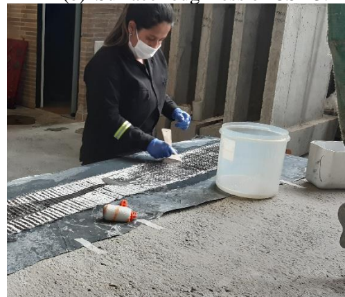
(d) Saturating of the FRP fabrics.
