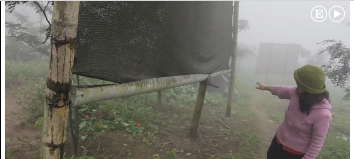
Ilustración 14. Estructura General del Atrapa Niebla
