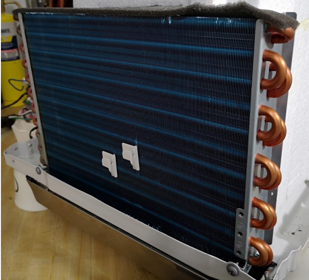
Ilustración 60. Serpentín del evaporador
