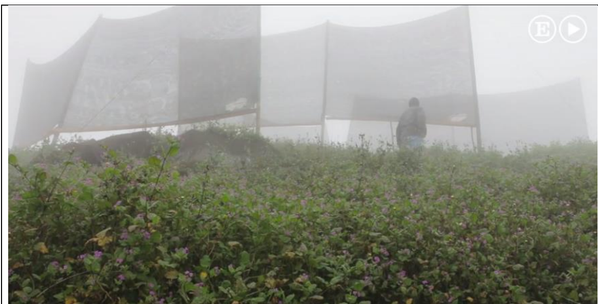
Ilustración 13. Redes atrapa nieblas instaladas en la ciudad de Lima
