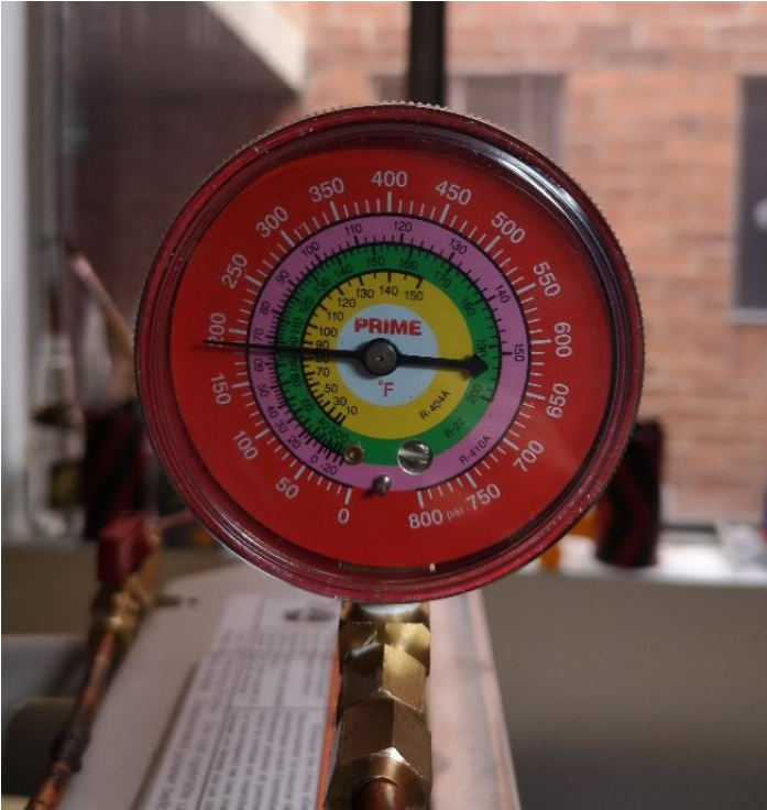
Ilustración 67. Manómetro para línea de gas de alta presión
