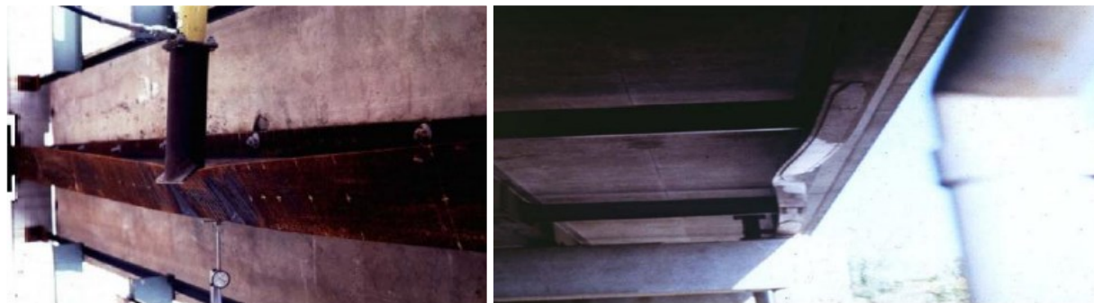
Figura 3-26. Daño por torsión.
