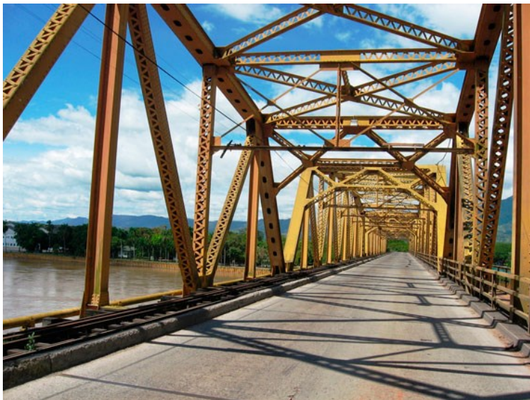
Figura 2-8. Puentes a través de Celosía en Colombia.
