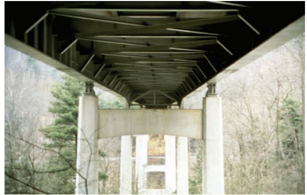
Figura 6. Puente de dos vigas, no redundante. [6]
