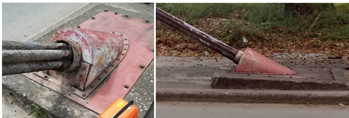
Figura 4-7. Anclajes Externos Lado surorientado.
