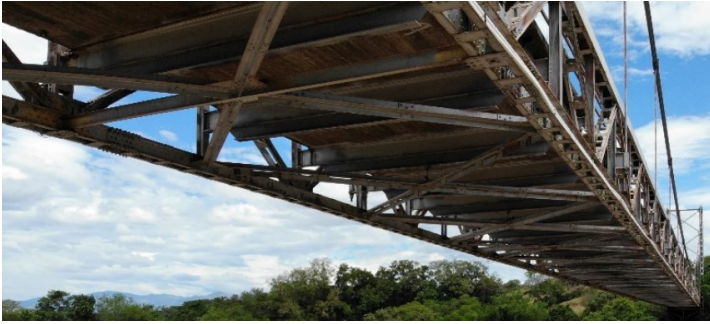
Figura 4-8. Cercha del Puente.
