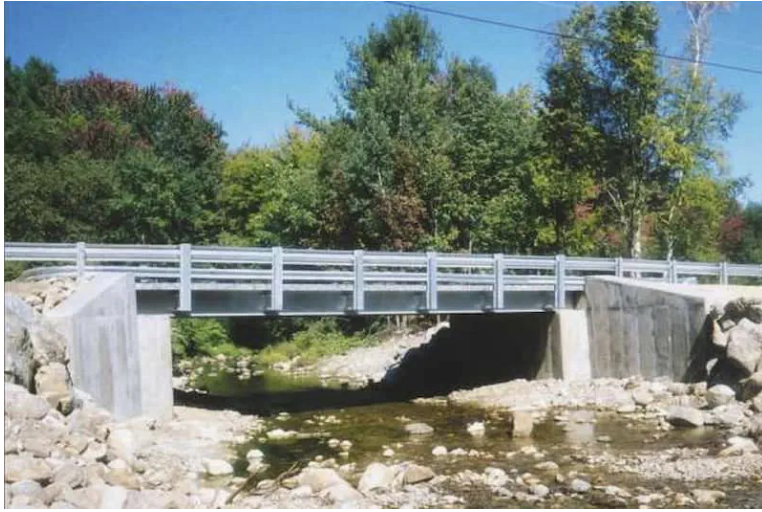
Figura 2-6. Puente en Vigas de Acero.
