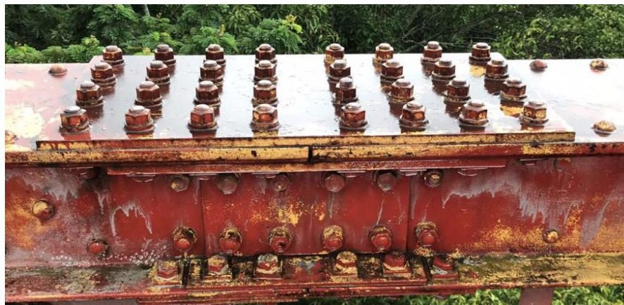
Figura 4-141. Superficie superior del cordón superior.
