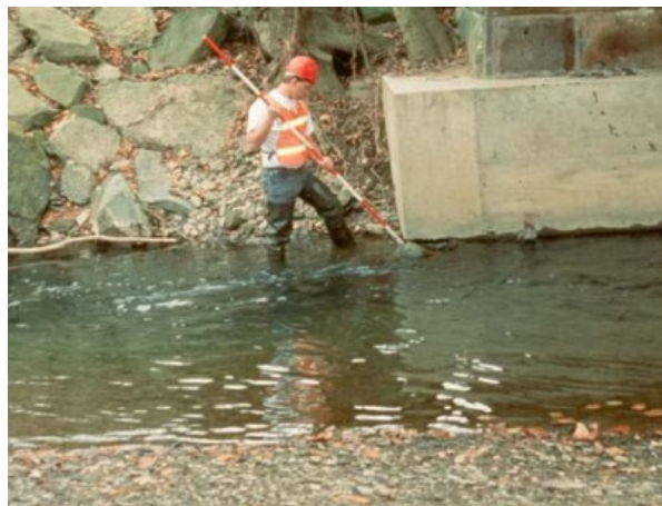
Figura 4. Inspección rutinaria de socavación.
