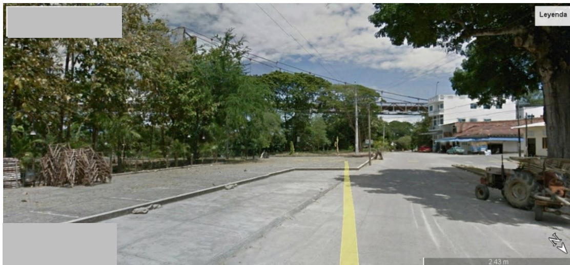
Figura 4-45. Imagen cerca del apoyo del puente
