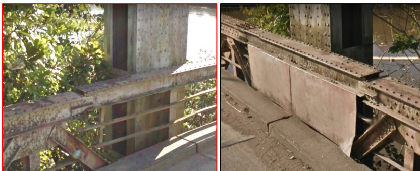
Figura 4-14. Izq. Cordón superior por extraer, aguas arriba. Der. Cordón superior aguas abajo.
