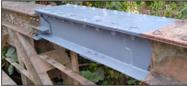
Figura 4-22. Protección del perfil nuevo.
