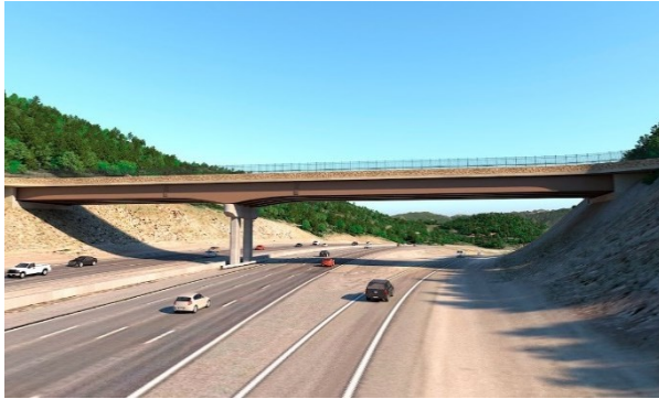
Figura 8. Puente de dos luces no redundante. [7]
