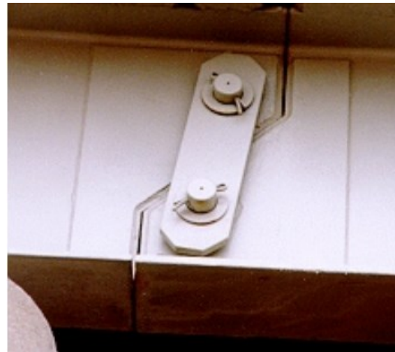
Figura 13. Ensamble de Pasador de Suspensión.[3]
