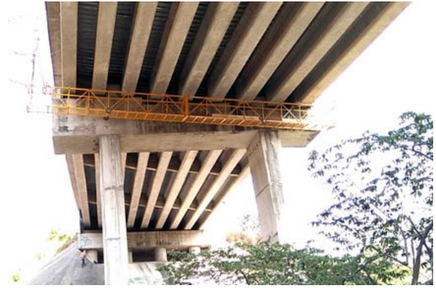
Figura 1. Plataforma para inspección y mantenimiento de puentes [1].
