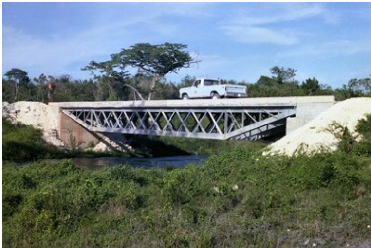
Figura 2-7. Puente sobre celosía en Belize.
