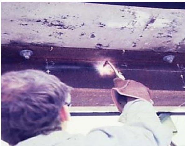
Figura 3-31. Calentamiento en línea en el alma.
