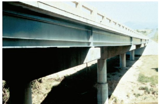
Figura 7. Puente de Luz Continua con Redundancia Estructural. [6]
