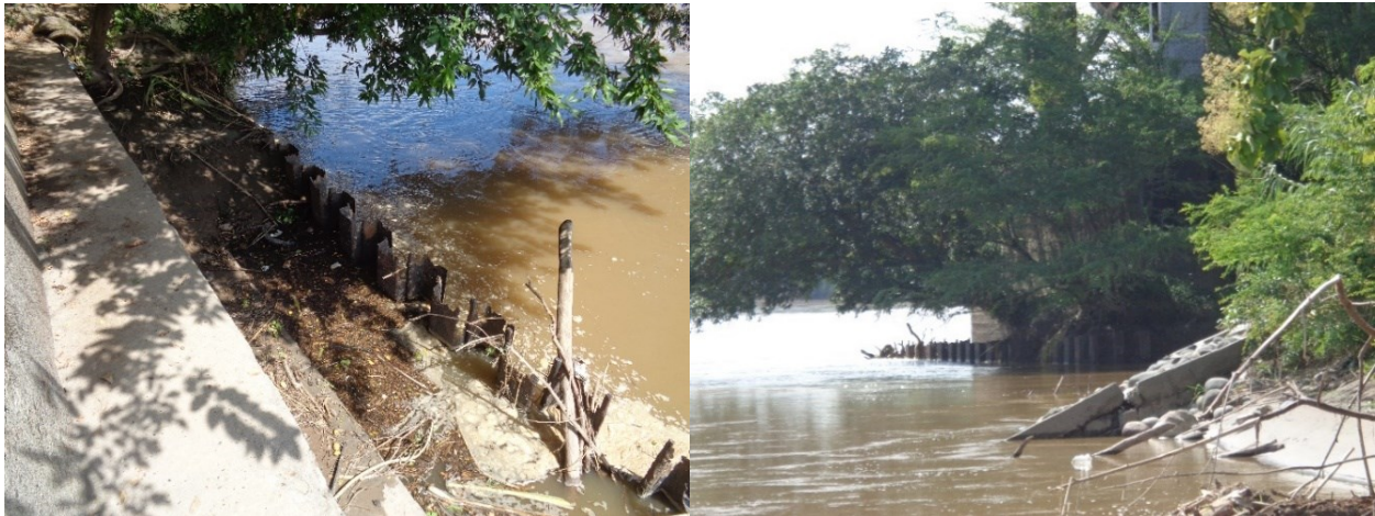
Figura 4-66. Cimiento de la pila principal del puente, en la margen izquierda del río.
