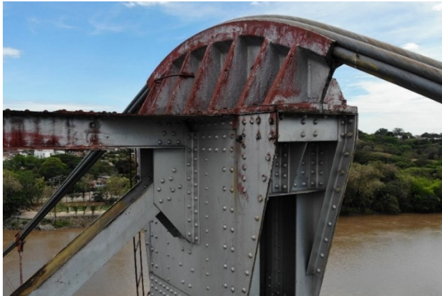
Figura 4-4. Galápago en Puente.
