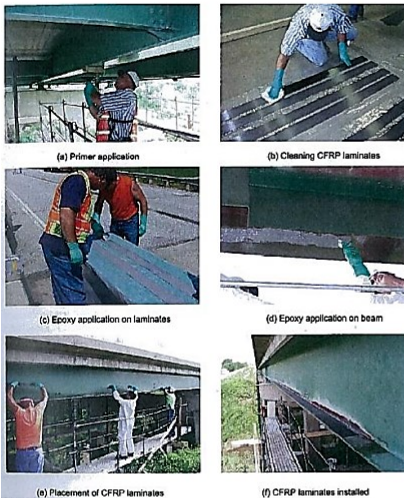
Figura 3-37. Procedimiento de Reforzamiento FRP.
