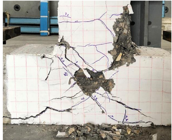
Ilustración 7 Falla Conexión Viga-Columna con cabeza. Fuente propia
