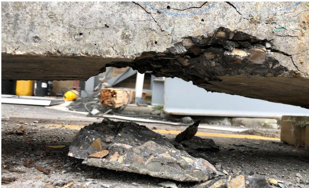
*Ilustración 62 Falla inferior recubrimiento. Barra # 6 profundidad 18 cm. Fuente propia*
