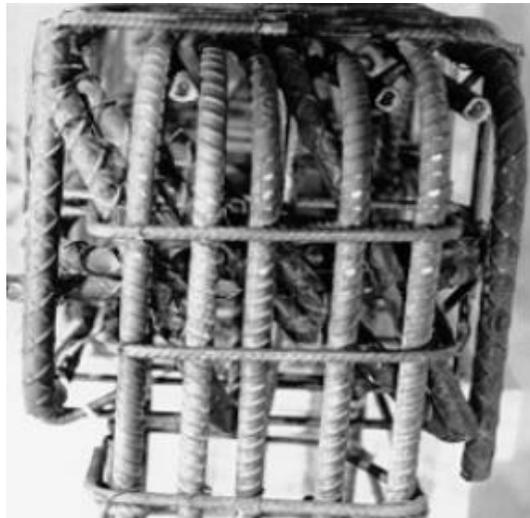
*Ilustración 1 Wallace, John (2016) Congestión de refuerzo en conexión viga columna.*
