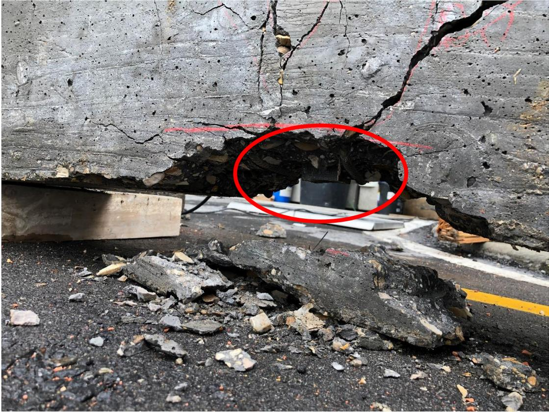
*Ilustración 63 Falla inferior recubrimiento. Barra # 7 profundidad 22.4 cm. Fuente propia*
