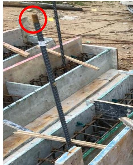
*Ilustración 47 Montaje: barras roscadas en parte superior. Fuente propia*
