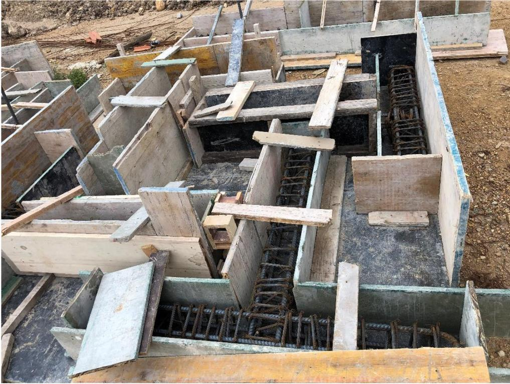
*Ilustración 42 Formaleta conexión viga columna. Fuente propia*
