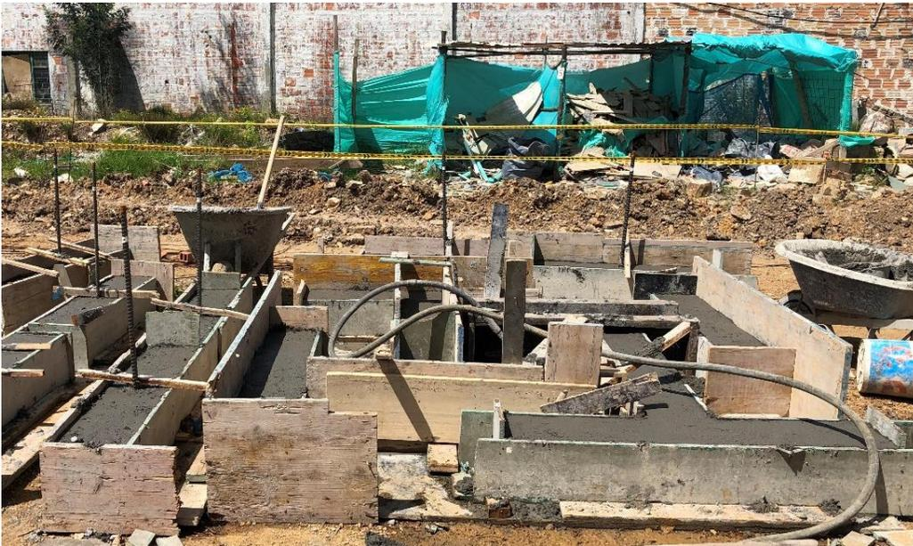
*Ilustración 43 Proceso de fundido espécimen y conexión viga-columna. Fuente propia*
