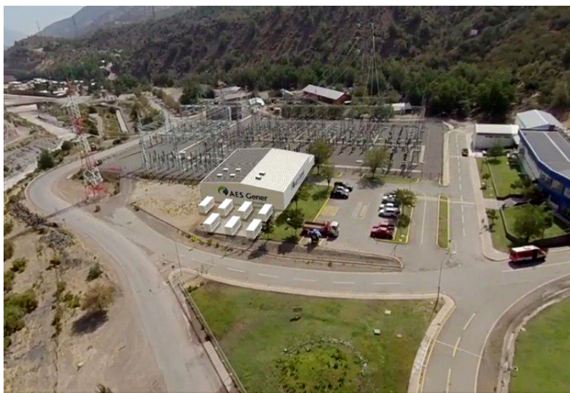
Figura 4.2: Sistema de almacenamiento de baterías y planta a filo de agua Alfalfal I.
