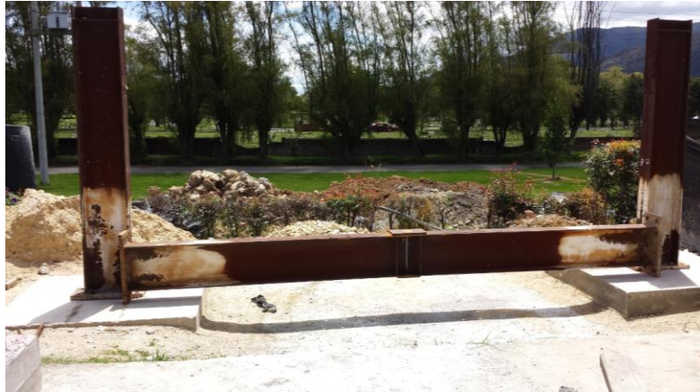
Figura 4-7: Montaje de viga IPE360
