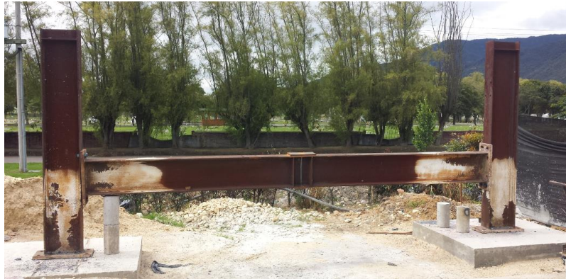
Figura 4-8: Anclaje de viga IPE360
