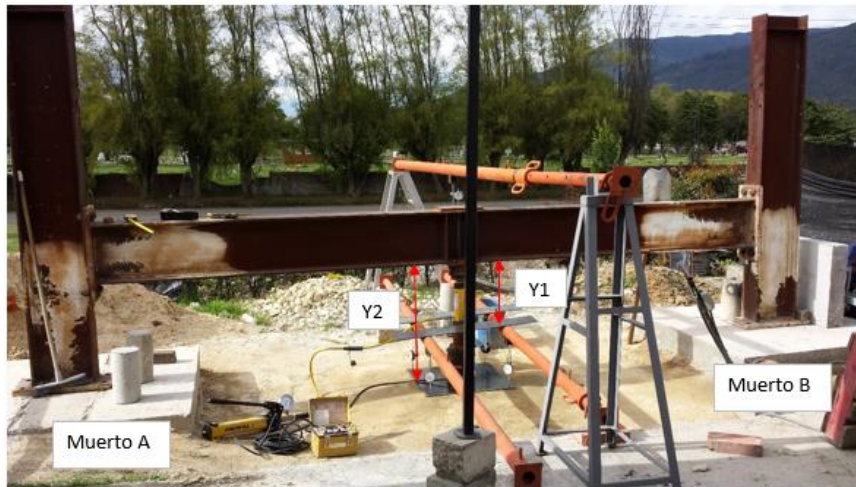
Figura 4-27: Instalación de deformímetros en platina 3/8"
