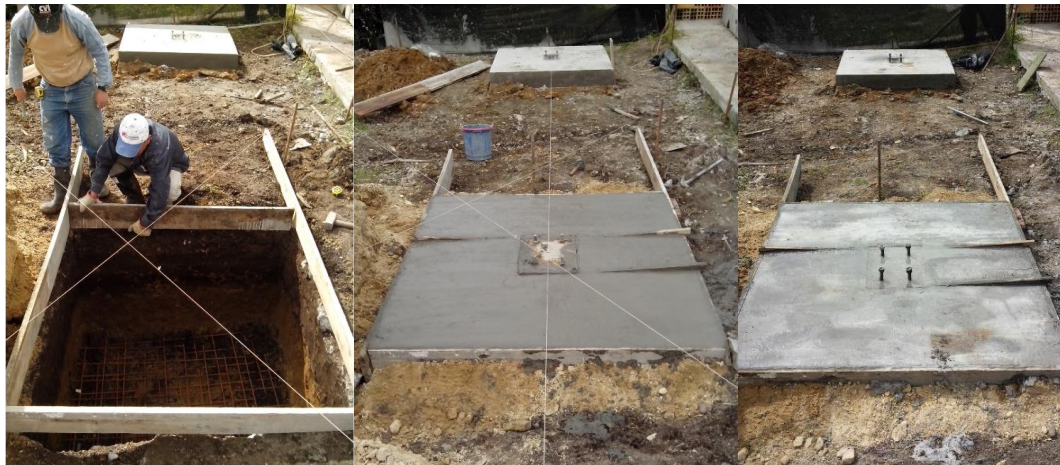
Figura 4-2: Construcción de muertos de concreto
