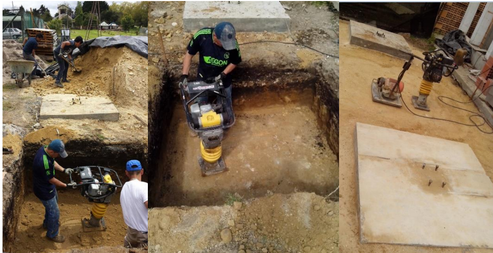
Figura 4-4: Compactación inicial, intermedia y final del material de relleno
