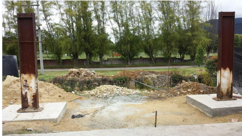
Figura 4-5: Instalación de columnas IPE360
