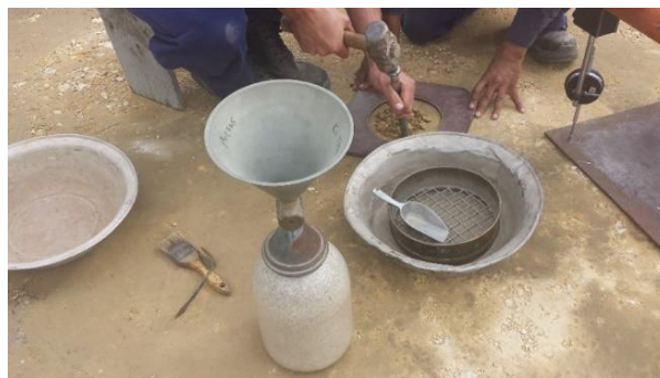
Figura 4-37: Toma de muestra para densidad y compactación del recebo 2
