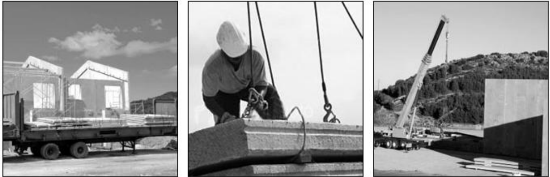
Figura 43 Montaje de componentes prefabricados
