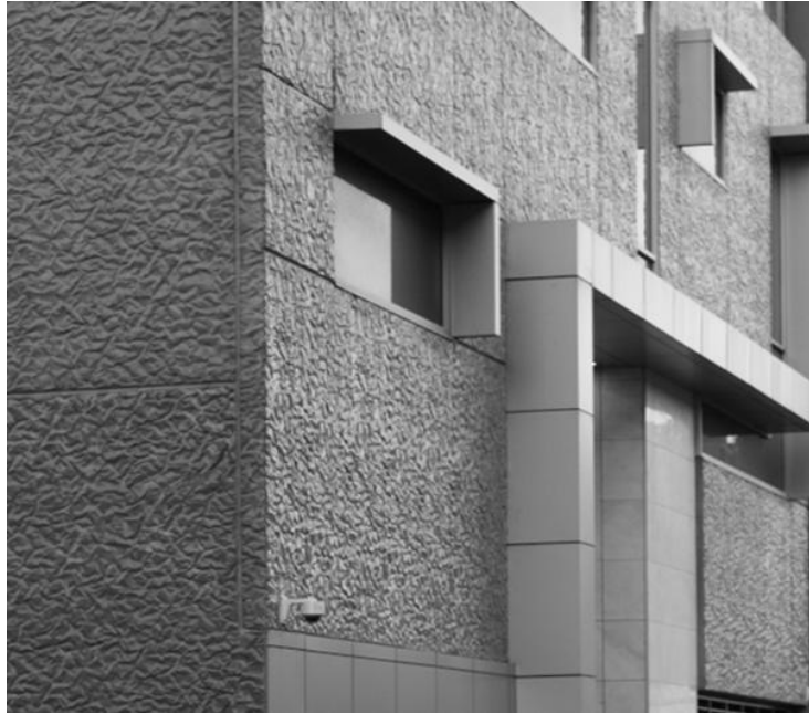
Figura 38 Fachadas prefabricadas en concreto arquitectónico
