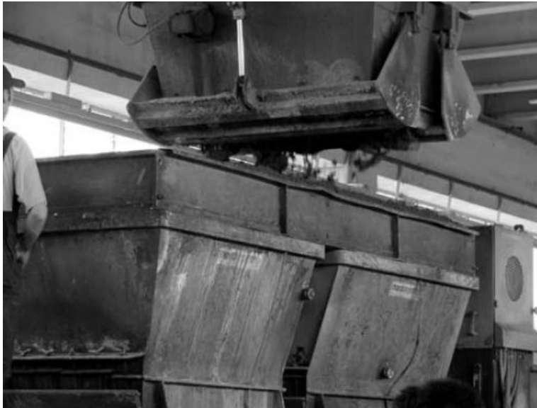
Figura 28 Alimentación de la máquina para vaciado de concreto
