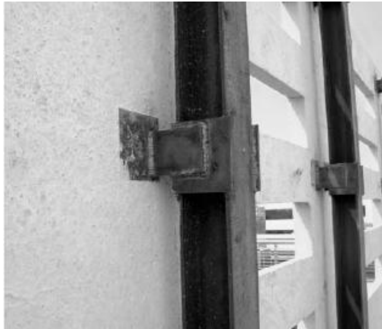
Figura 40 Conexión soldada de panel de fachada
