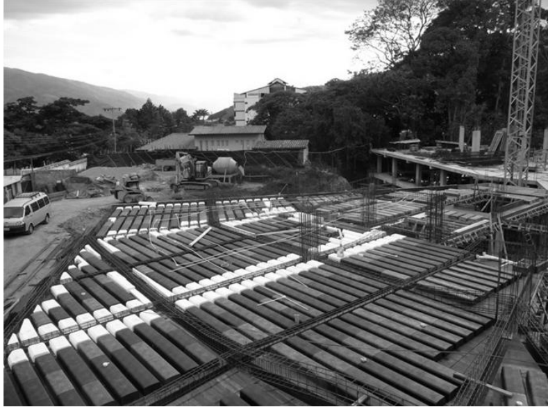
Figura 68 Armado de entepiso de losa nervada con casetón recuperable
