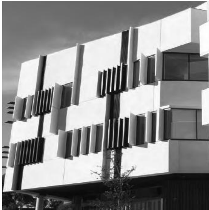
Figura 15 Sistema de fachada con antepechos prefabricados
