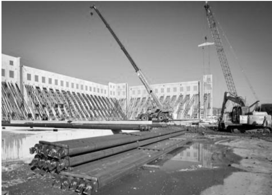
Figura 13 Muros prefabricados Tilt-Up y su montaje
