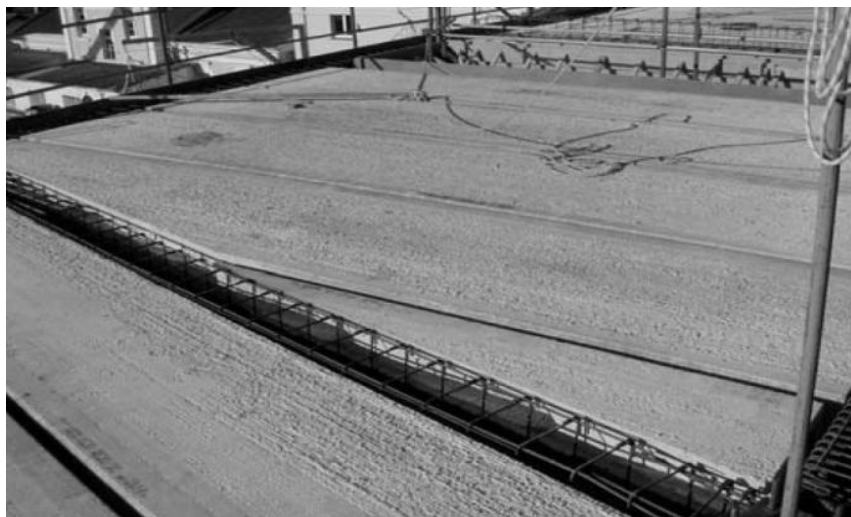
Figura 45 Corte oblicuo de losa alveolar para entrepiso
