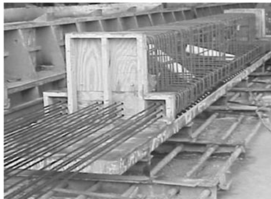
Figura 6. Formaleta en madera para vigas “T” invertidas
