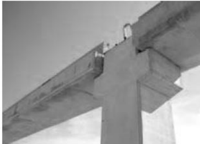
Figura 34 Unión Viga-Columna prefabricada
