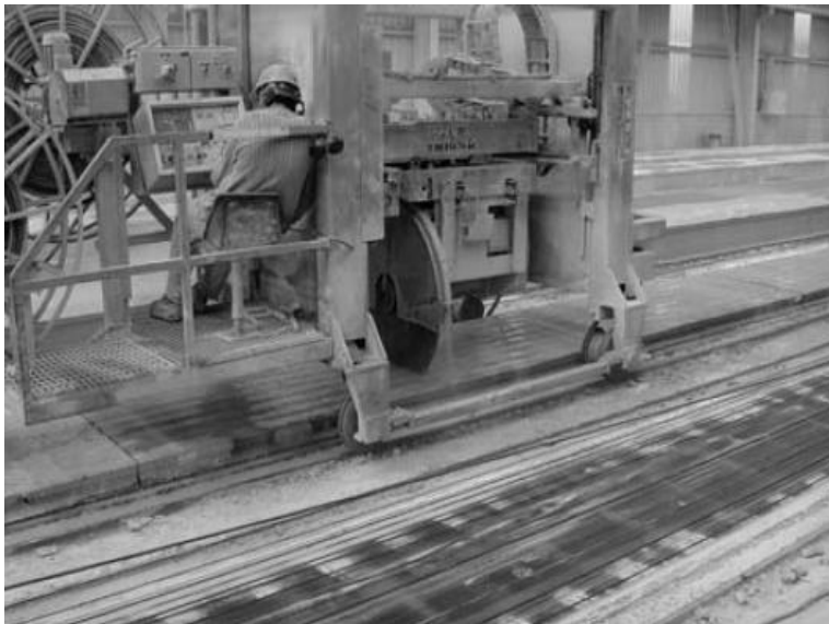
Figura 29 Corte de losa alveolar con disco diamantado
