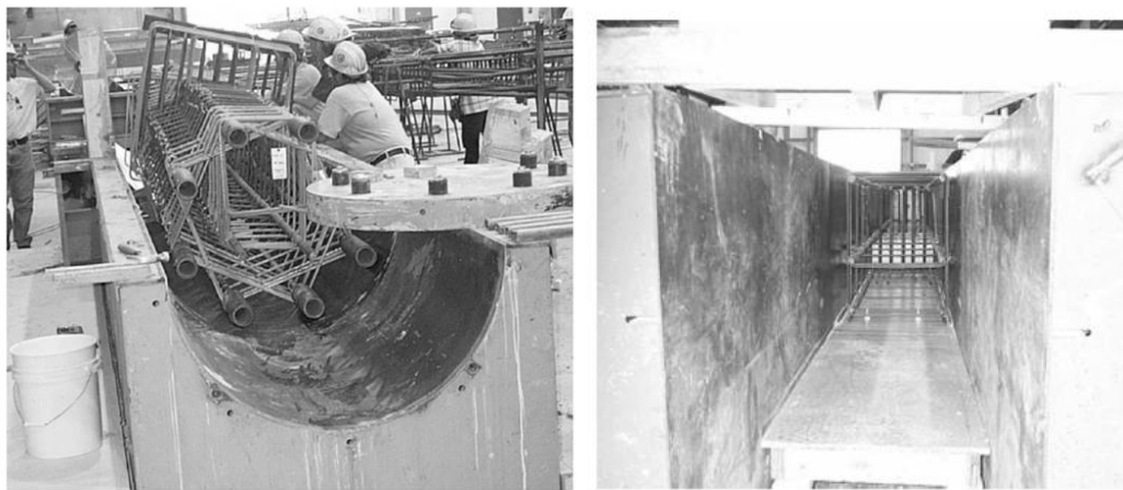
Figura 5. Formaleta en acero para columnas circulares y rectangulares
