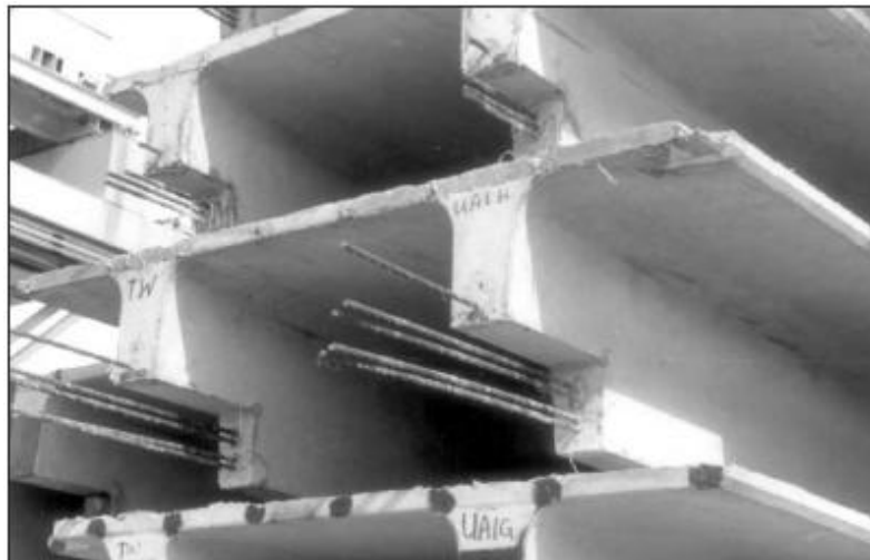
Figura 20 Losa prefabricada en doble T
