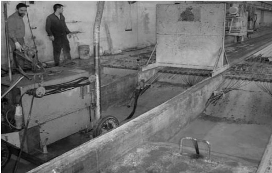
Figura 26 Tensionamiento de armadura para losas alveolares
