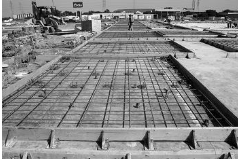
Figura 8. Formaleta en madera para muros prefabricados en sitio
