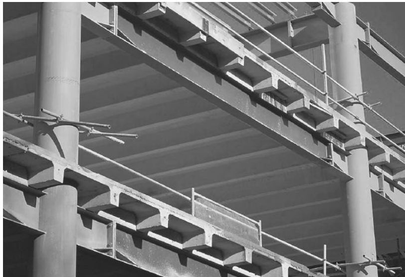
Figura 21 Aplicación losa prefabricada en doble T en edificaciones metálicas
