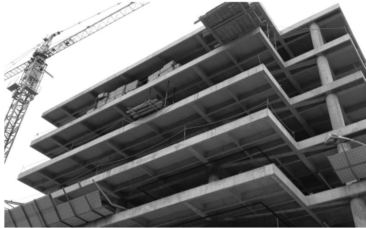
Figura 64 Entrepisos de losa maciza con vigas descolgadas
