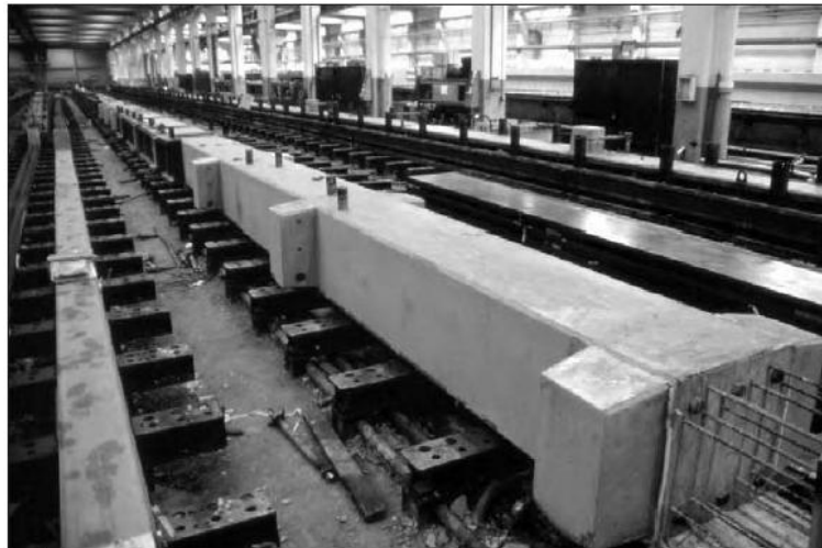
Figura 36 banco de prefabricación para columnas con iguales alturas de entrepiso
