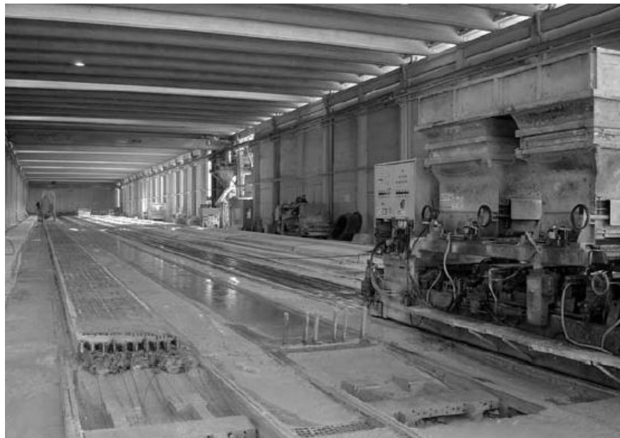
Figura 25 Pistas de fabricación de losas alveolares
