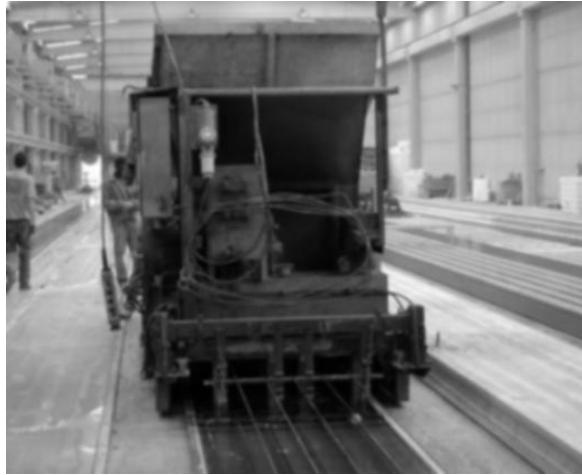
Figura 27 Maquina extrusora y de vertido de concreto
