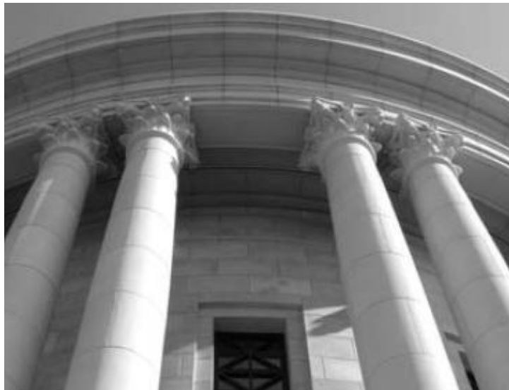
Figura 44 Concreto arquitectónico prefabricado de apariencia pétreo
