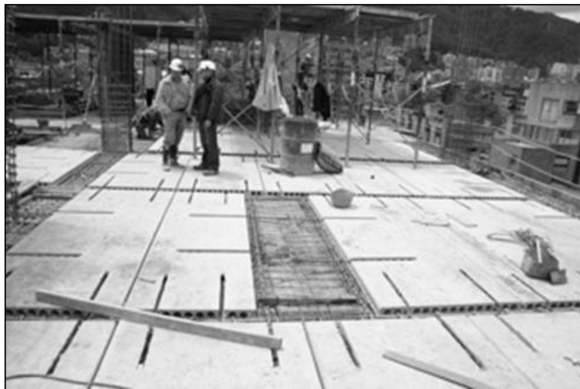
Figura 62 Armado del sistema de entrepiso alveolar apoyado sobre vigas fundidas en sitio
