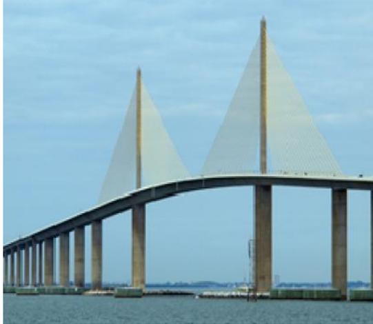
El Puente Sunshine Skyway es un puente que cruza Tampa Bay, Florida. Tiene un atirantado vano principal con una longitud de aproximadamente 8.85 kilómetros. Con la aplicación de concretos de alto desempeño se realizan mantenimientos para evitar la corrosión del acero en los prefabricados de columnas segmentarias. Se ha requerido entrar en la superestructura del puente para reforzar sus secciones.
