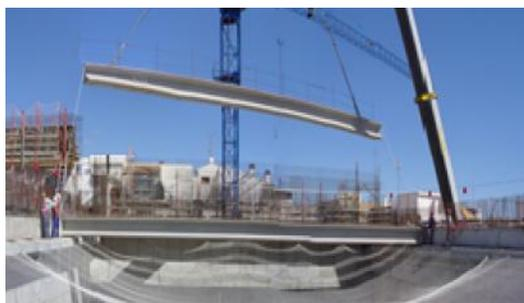
Están diseñadas y fabricadas en diferentes geometrías, cantos y longitudes. solucionan diferentes condiciones de carga, luces, etc.
