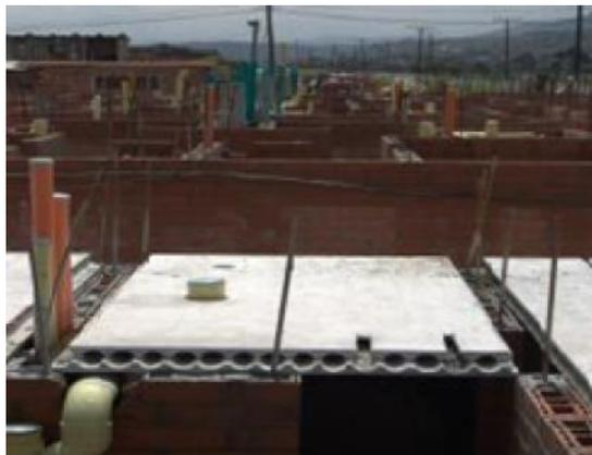
Losas en concreto prefabricado con espesor pequeño que se aplican en sistemas de entrepiso de acuerdo a especificaciones de proyecto. Se fabrican a la medida en donde se requiere este tipo de losa. Son fáciles de transportar, maniobrar, permiten mantener orden y limpieza en obra sin la necesidad de colar en sitio y usar cimbras, lo cual genera ahorros en cuestión de tiempos de ejecución, entre otros.
