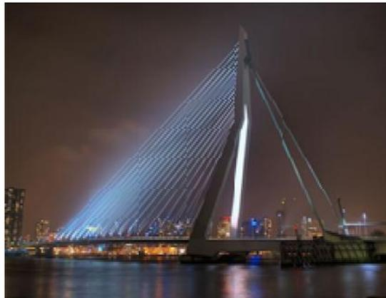
El puente Erasmusbrug esta localizado en Holanda, el pilón asimétrico con forma de horquilla o de "cisne" define el carácter innovador. El pilón sostiene 32 tirantes, tiene aproximadamente 800 m de longitud y una altura de 139 m. Al poco tiempo de su apertura se descubrió que el puente era inestable por el viento y mediante un sistema de amortiguamiento anti-shock se logró neutralizar las vibraciones que producían las turbulencias eólicas.
