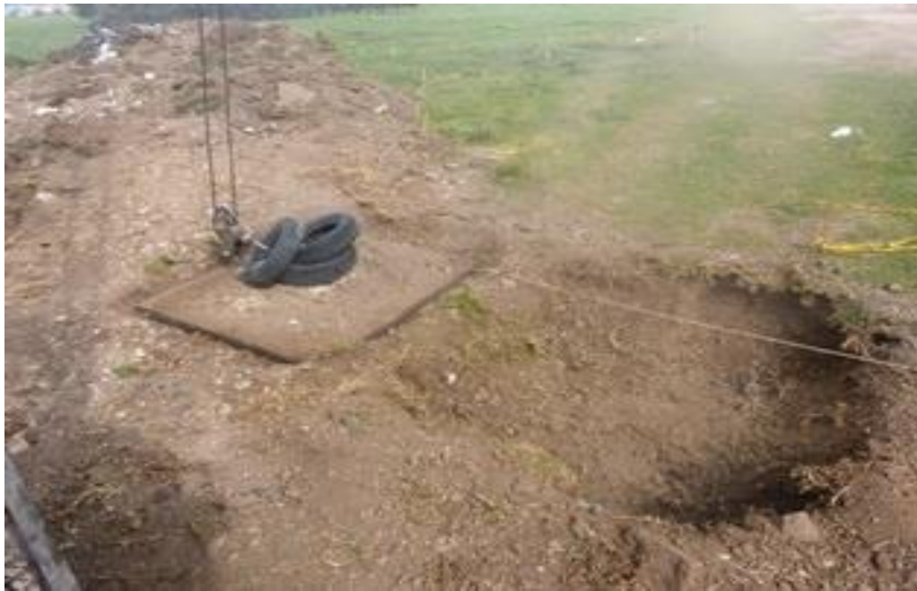
Figura 8 Una vez terminado el primer cuadro, se inicia el segundo separado 0.5m del borde del primer cuadro.
