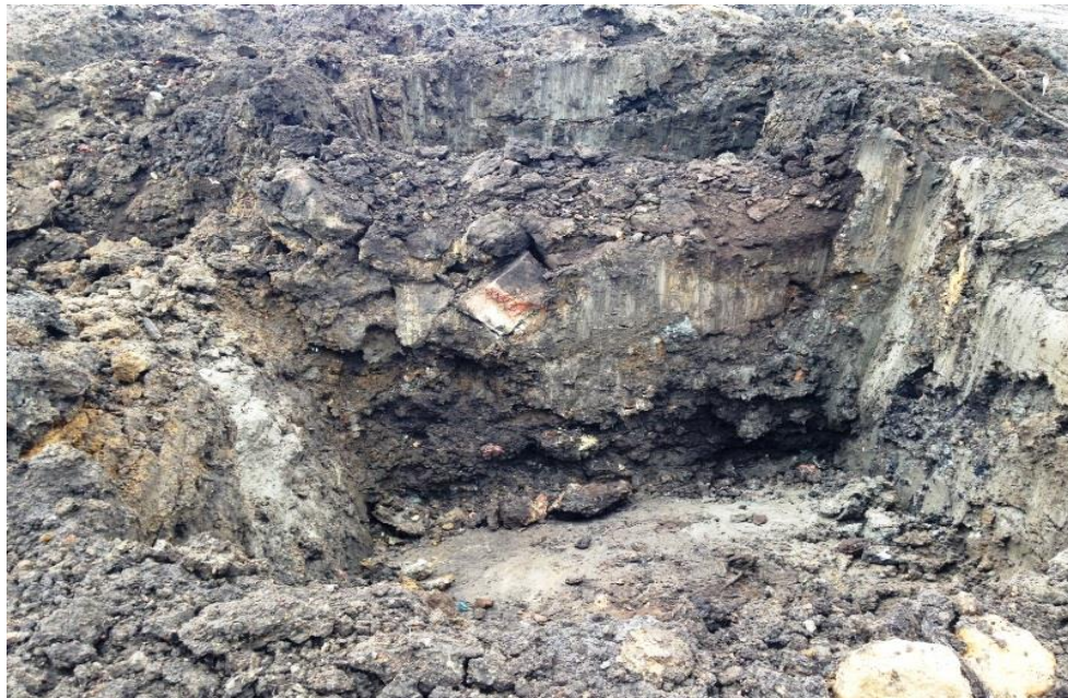
Figura 11 Depresión en suelo cohesivo
