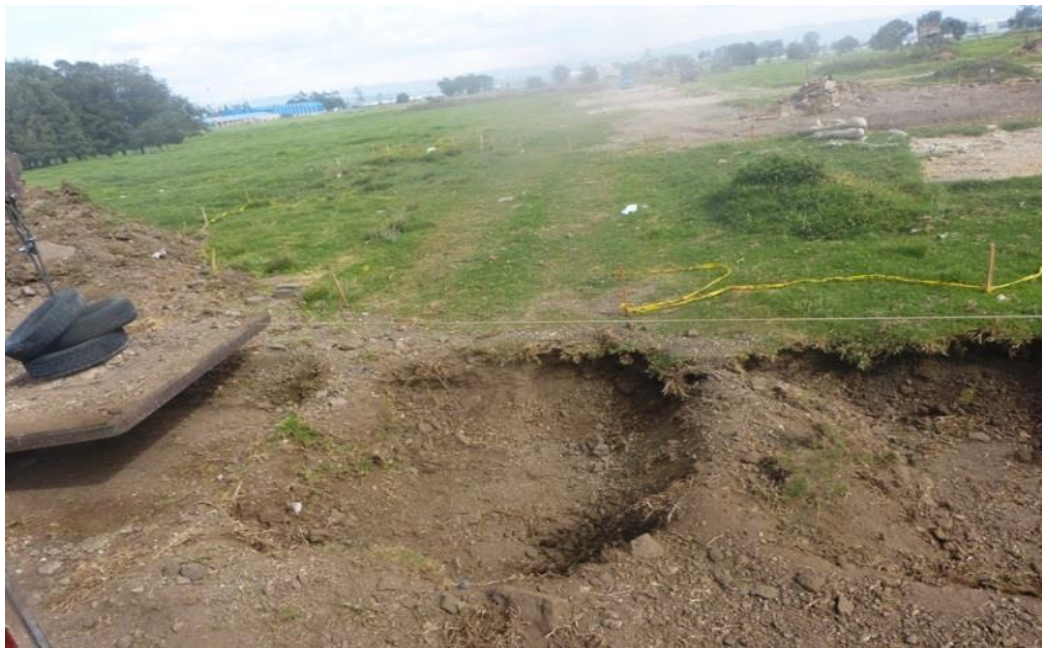
Figura 9 Una vez terminado el segundo cuadro, se inicia el tercero separado 0.5m del borde del segundo cuadro, y así sucesivamente hasta abarcar toda el área del lote a densificar siguiendo la grilla.
