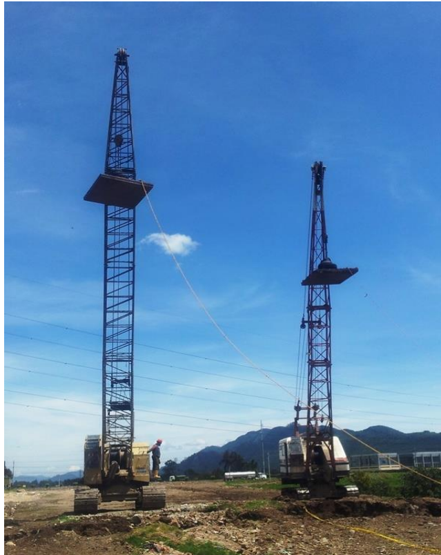
Figura 2 Grúas empleadas en el mejoramiento del suelo para cimentar superficialmente una bodega ubicada en el parque industrial Celta (Bogotá).
