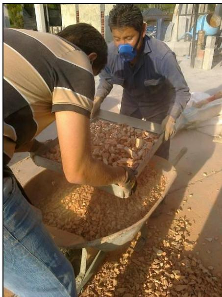
**Figura 11. Tamizado manual del ladrillo triturado.**
