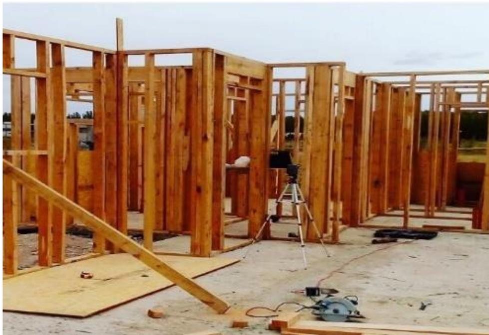
Figura 1 Construcción de vivienda en Wood frame. Fuente: AZ Construcciones - Argentina.
