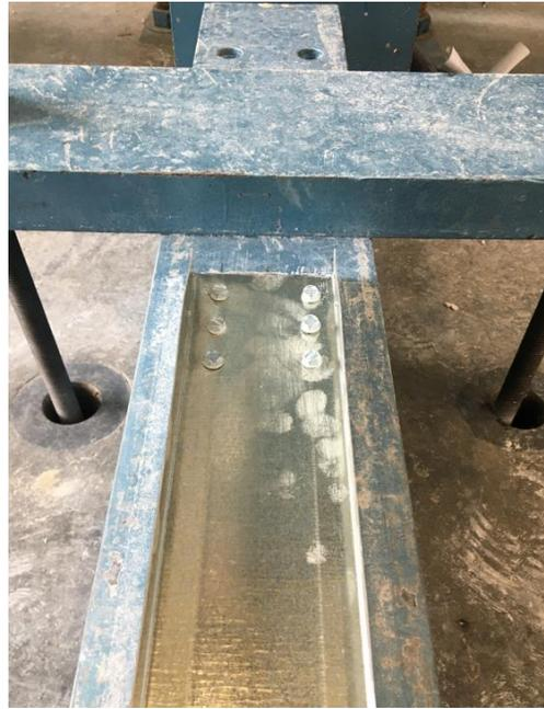
Fotografía 6 Anclaje de solera a viga
