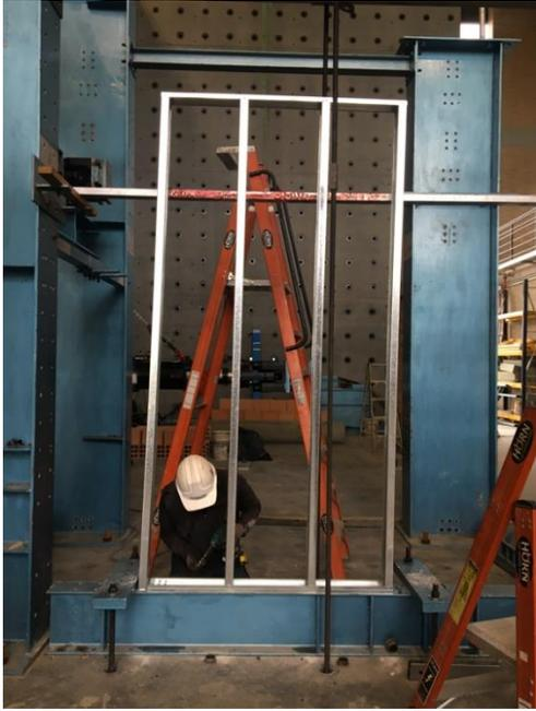
Fotografía 5 Anclaje del marco a la viga
