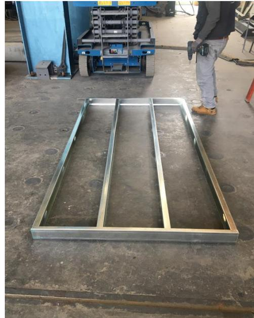
Fotografía 2 fijación de los perfiles en su posición
