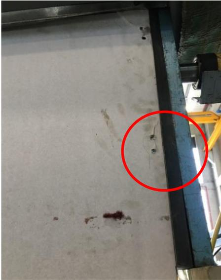
(a) Desgarramiento del revestimiento en la zona superior del panel.
