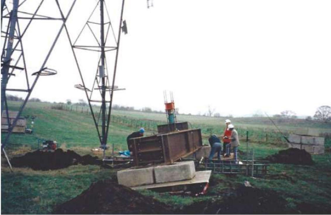
**Figura 3-15. Prueba a gran escala de una cimentación existente.**
