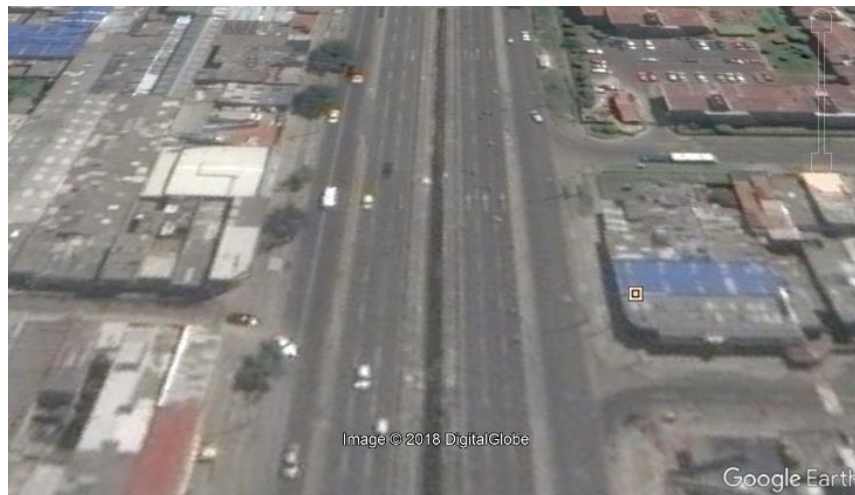
Figura 19. Av. Boyacá Tramo 2. Estado Actual.
