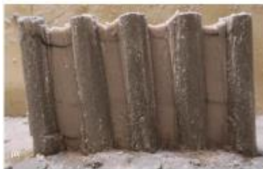
Figura 7 Columnas suelo - cemento después del ensayo. Fuente: Pourakbar, et al, 2020
