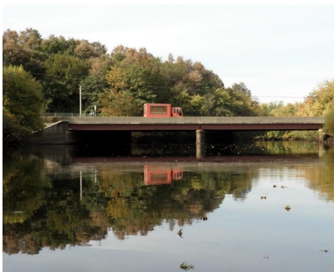
Figura 28 Puente NJ 159 WB sobre río Passaic.
