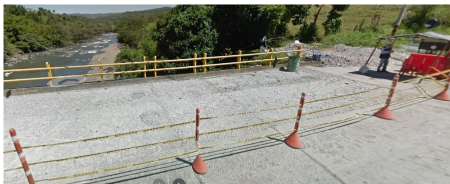
Figura 38 Proceso de rehabilitación Puente La Libertad 4. Fuente: Google Maps
