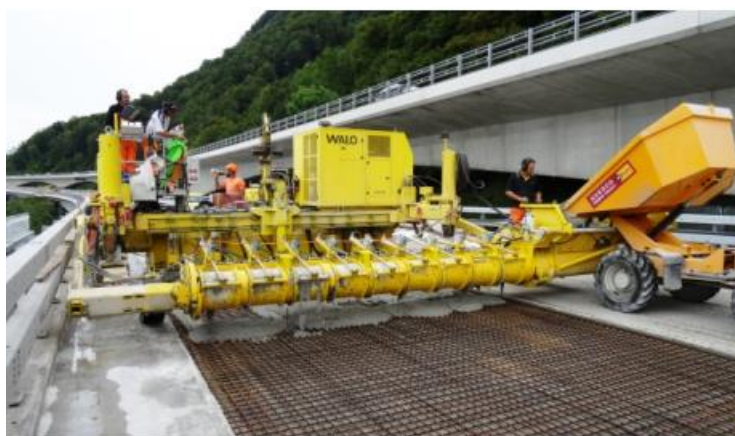
Figura 34. Máquina Empleada en la Colocación del UHPFRC (Brühwiler, y otros, 2015).
