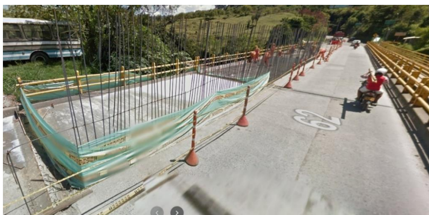
Figura 35 Proceso de rehabilitación Puente La Libertad 1. Fuente: Google Maps
