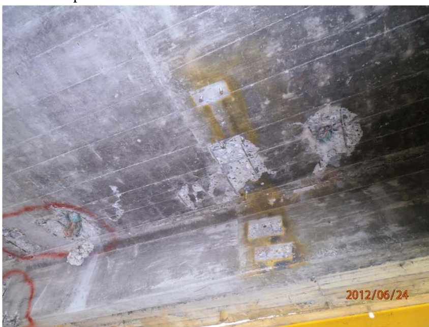
Figura 20 Losa Puente la Libertad. (SiPuCol, 2012)
