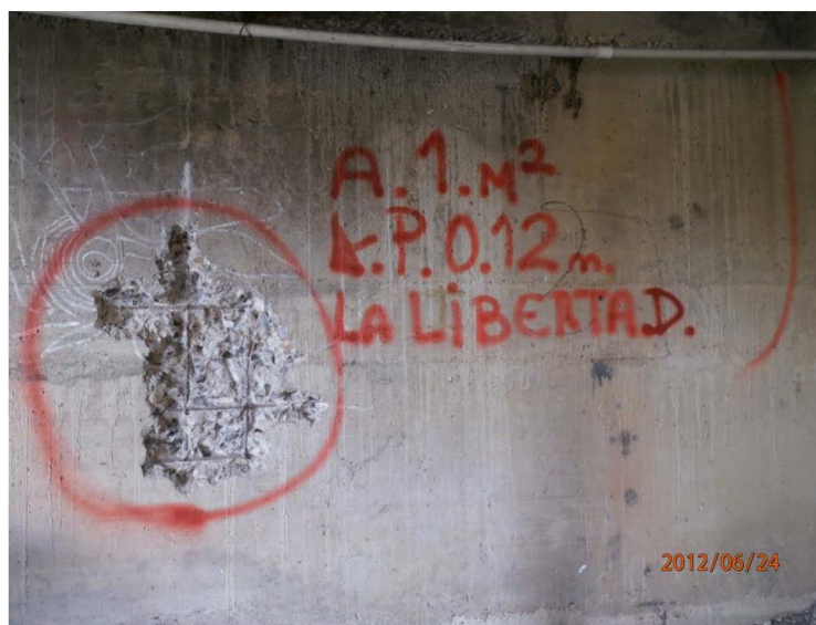
Figura 18 Estribo #2 Puente La Libertad. (SiPuCol, 2012)
