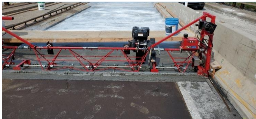
Figura 27 Regla vibradora utilizada en Brucke Expressway sobre St. Ann's Avenue. (UHPC Solutions North America, 2022)
