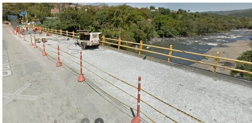
Figura 37 Proceso de rehabilitación Puente La Libertad 3. Fuente: Google Maps
