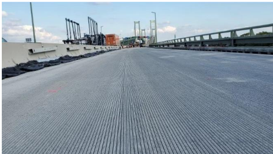
Figura 25 Superficie de capa de rodadura DMB. (UHPC Solutions North America, 2022)
