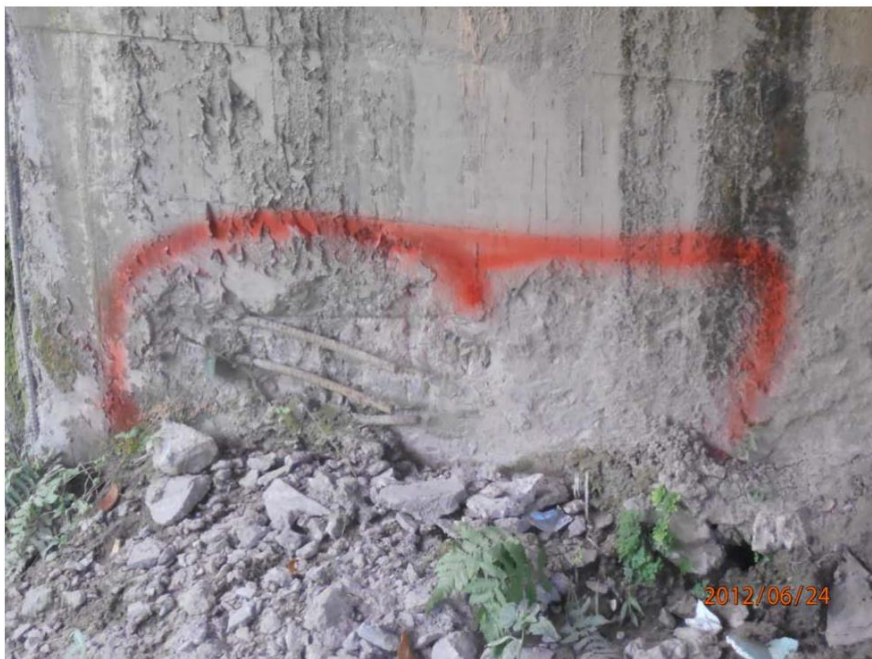
Figura 19 Estribo #1 Puente La Libertad (SiPuCol, 2012)
