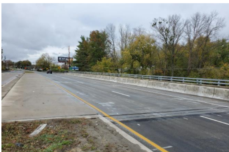
Figura 29 Capa de rodadura del Puente NJ159 WB sobre el río Passaic
