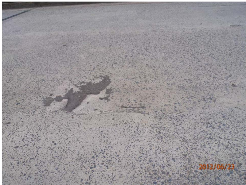
Figura 17 Superficie del Puente la Libertad (SiPuCol, 2012)
