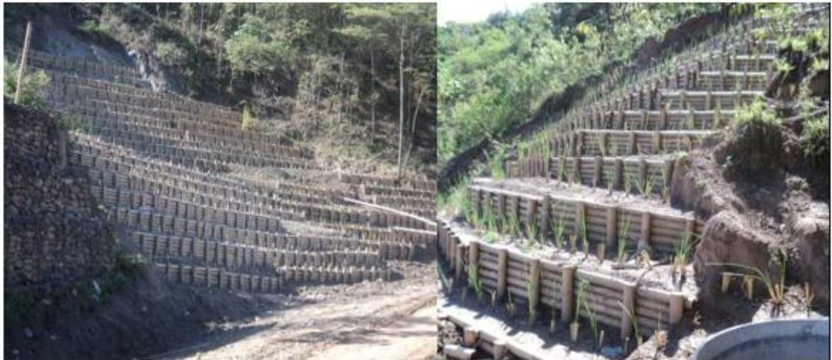
Foto 12 Trabajo de campo: Pasto Vetiver sembrado en el talud. Vía Neiva-Vegalarga
