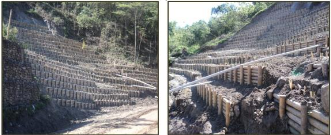
Foto 30 Proceso final de plantación del pasto Vetiver, los trinchos y los drenes
