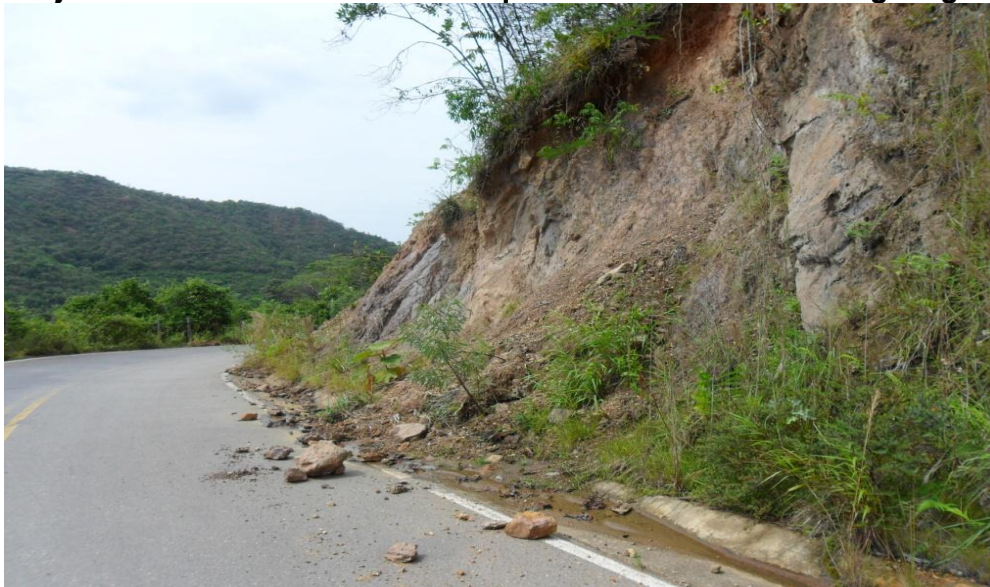
Foto 8 Flujo de detritos en talud de la vía que conduce de Neiva a Vegalarga
