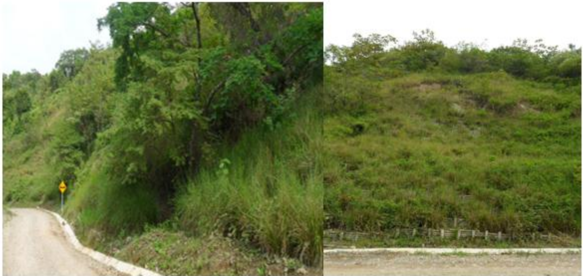
Foto 14 Plantas en desarrollo sembrada en talud. Vía Neiva-Vegalarga
