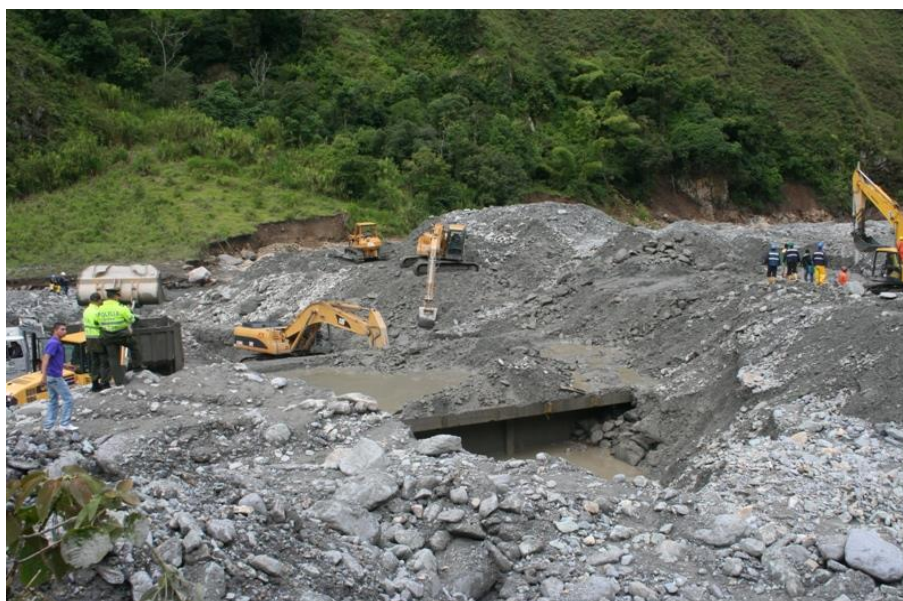
Figura. 5-7. Avalancha de la quebrada Estaquecá, 2019 Fuente: Hidroconsulta S.A.S
