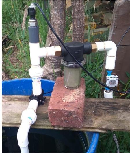
**Figura 30** Montaje bomba de riego
