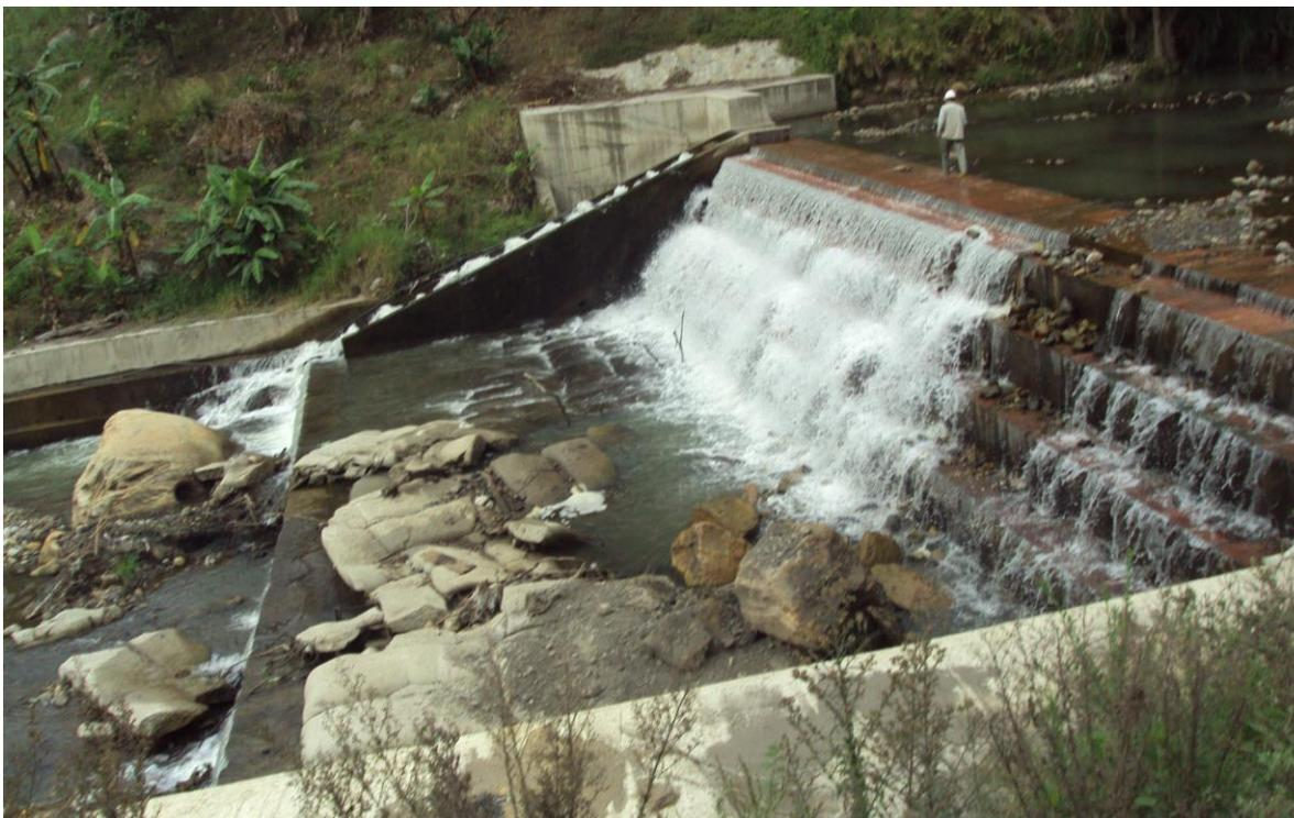
**FIGURA 5.3.** Vista de uno de los azudes existente en el K18. Se observa en la margen derecha la escalera para peces. De manera similar se puede adosar un canal de derivación desde el vertedero, por la margen izquierda. (Hidroconsulta S.A.S, 2013).
