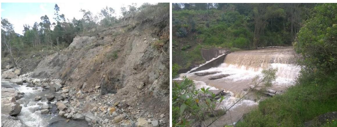
**FIGURA 1.2. Izquierda:** Procesos de socavación y erosión en el río Cáqueza. **Derecha:** Diques en concreto ciclópeo tipo Azud de 4 metros de altura a nivel de vertedero, con los cuales se ha logrado el control local de dichos procesos. (Hidroconsulta, 2018).
