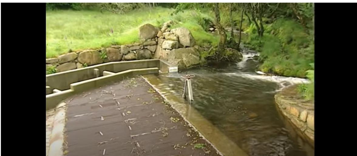
**FIGURA 5.4.** Captación lateral por medio de una estructura tipo Azud. Tomado del video ¿Qué es una pequeña central hidroeléctrica? Del canal Hidraliaenergía de Youtube.
