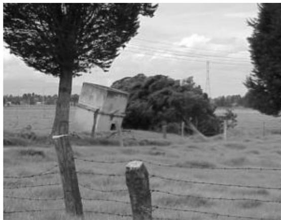
Figura 9. Asentamiento diferencial por fisuras de desecación.
