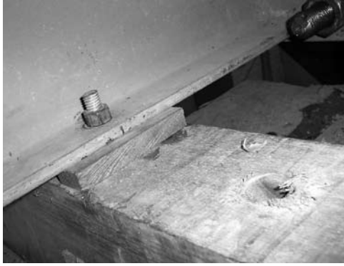
Figura 8: Detalle del sistema de aplicación de carga. Pernos de unión entre el perfil y los elementos de madera.
