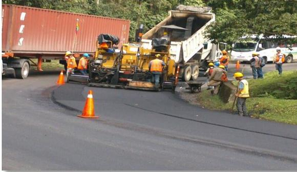
*Ilustración 6. Rehabilitación estructura de pavimento (carpeta asfáltica)*
