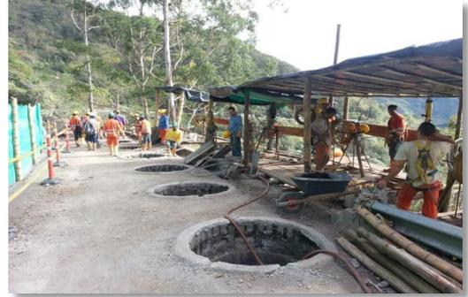
*Ilustración 7. Construcción de estructuras de contención*
