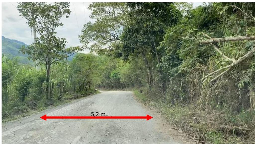
*Ilustración 14: Imagen de una sección del corredor con su ancho. Fuente: Registro fotográfico propio*
