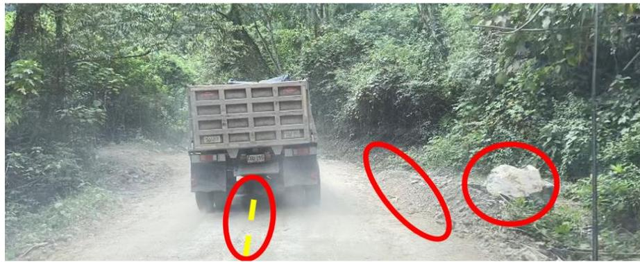
*Ilustración 18: Ausencia de señalización horizontal, pérdida total de zona lateral y presencia de obstáculos naturales potencialmente peligrosos. Fuente: Registro fotográfico propio*
