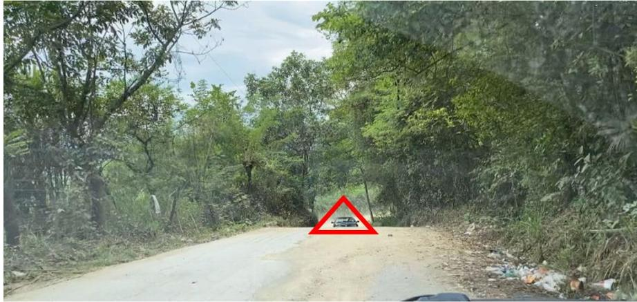
*Ilustración 17: Pérdida de visibilidad del trazado en vertical. Fuente: Registro fotográfico propio*
