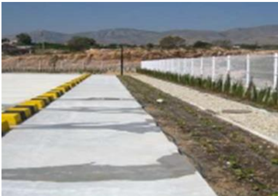
Figura 5.13 Zanjas de infiltración. (36) (2)
