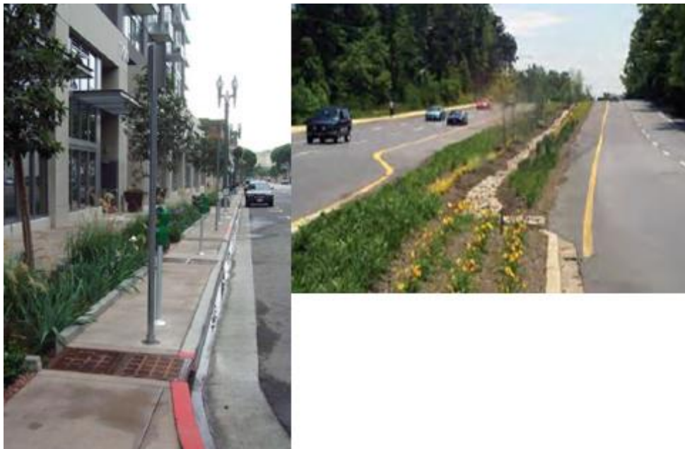
Figura 5.18 Biofiltros (a la izquierda celda de biorretención de la calle, Los Ángeles CA, a la derecha biorretención de área lineal a lo largo de la carretera)
