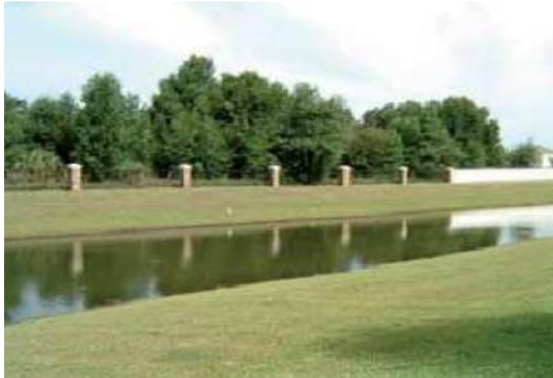
Figura 5.24 Estanque de retención. (36).
