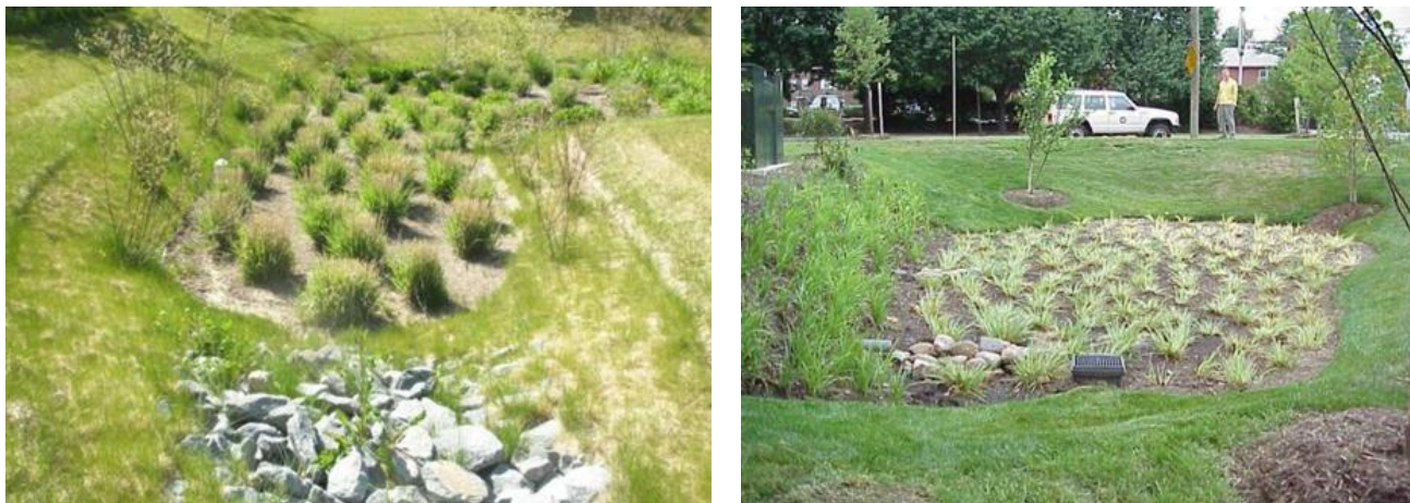
Figura 6.8 Zanjas vegetadas. Biorretención (38) (31)
