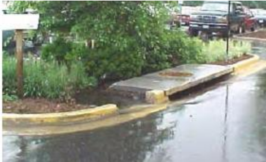
Figura 5.17 Zona de biofiltro en un estacionamiento junto con un sumidero convencional para evitar el desbordamiento del biofiltro (31)
