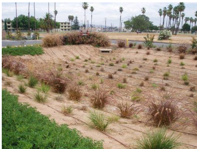
Figura 5.21 Depósito de infiltración. (31)
