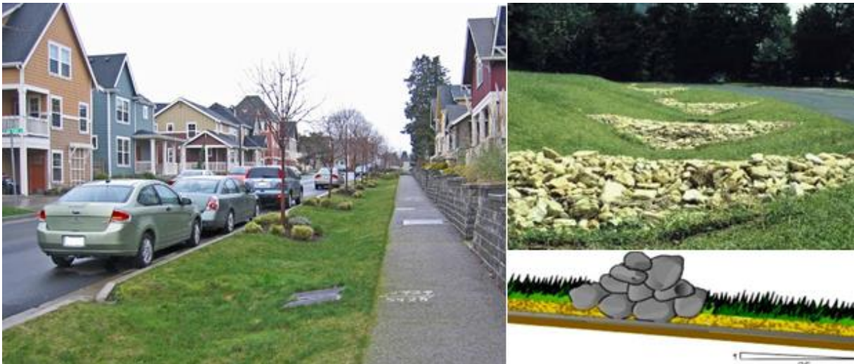
Figura 5.19 Cunetas verdes. Cunetas con diques y muros. (2)
