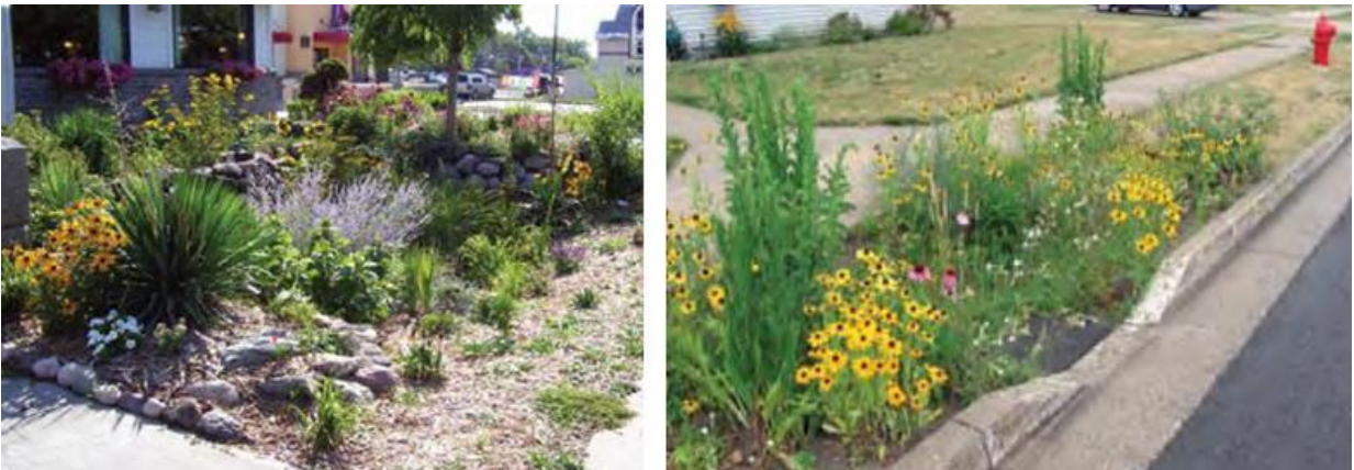
Figura 5.16 Estructuras de biorretención (a la derecha biofiltro ubicado en una zona residencial, a la izquierda como estructura de captación sobre una vía urbana) (31)
