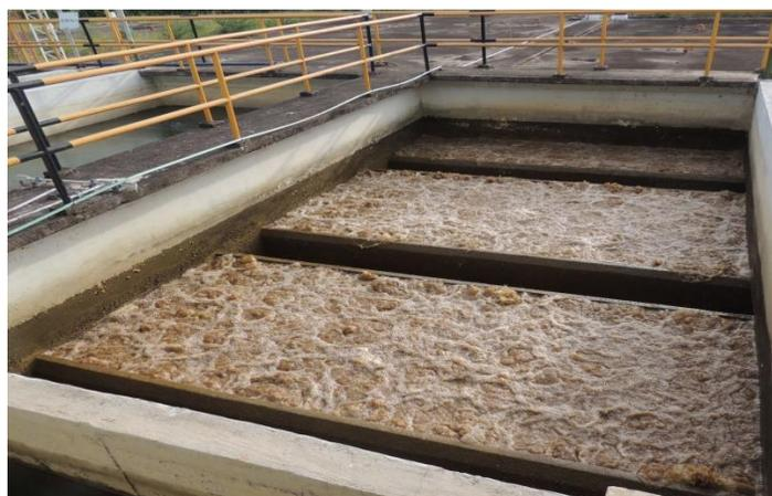
Figura 21. Tanque de filtración el agua se agita por el bombeo de aire
