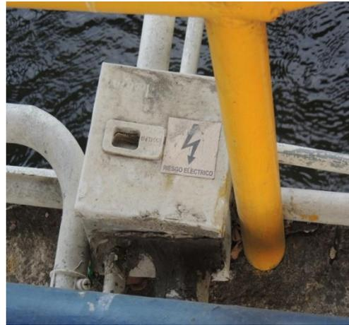
Figura 29. Caja eléctrica en los corredores de los tanques de sedimentación
