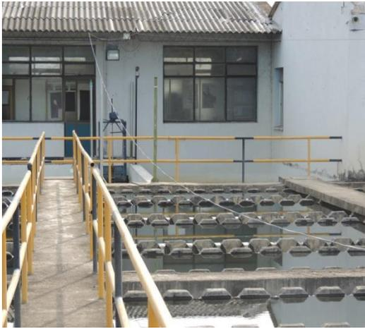
Figura 28. Cable con electricidad descolgado sobre los tanques de sedimentación.
