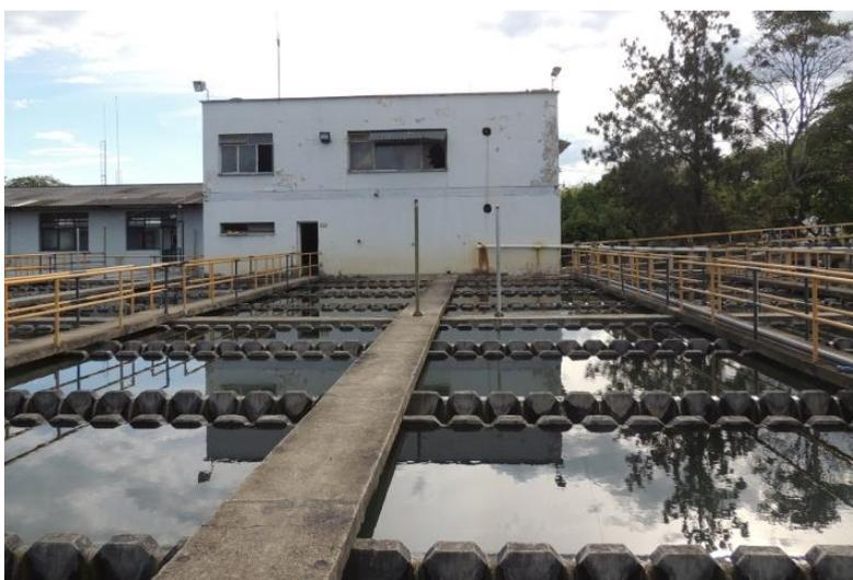
Figura 19. Tanques de Sedimentación
