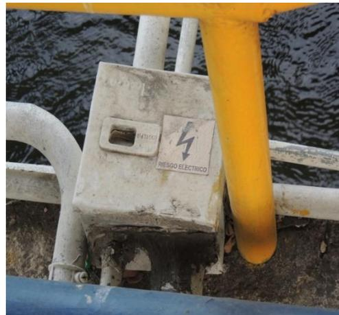
Figura 45. Posibilidad de contacto con fuente electricidad
