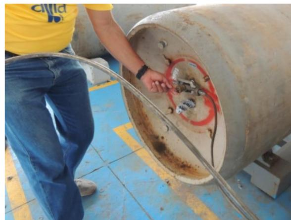
Figura 41. Precauciones con la trampa (válvula de seguridad del cilindro con cloro. Fuente: Los autores
