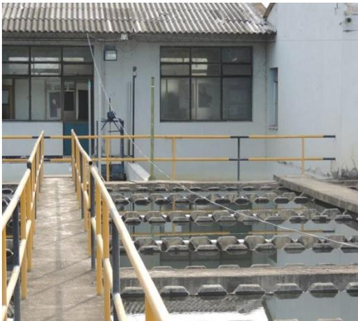
Figura 44. Cable con electricidad descolgado sobre los tanques de sedimentación.
