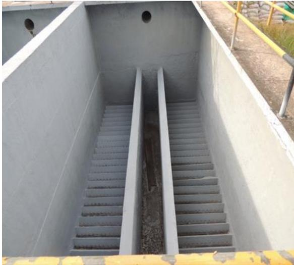
Figura 25. Tanque de Filtración vacío profundidad 4.30 metros.
