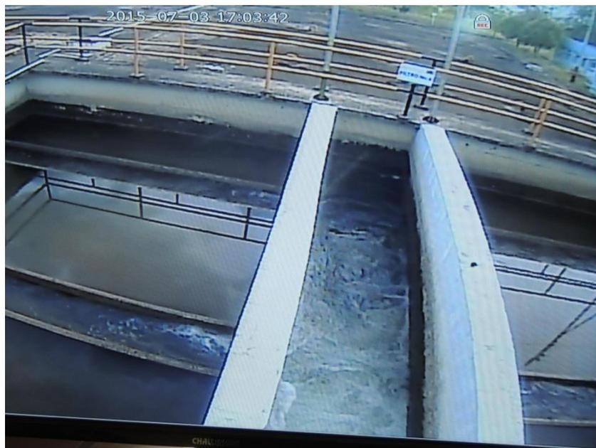
Figura 46. Monitoreo computarizado vista tanque de filtración durante el lavado hay considerable consumo de agua.
