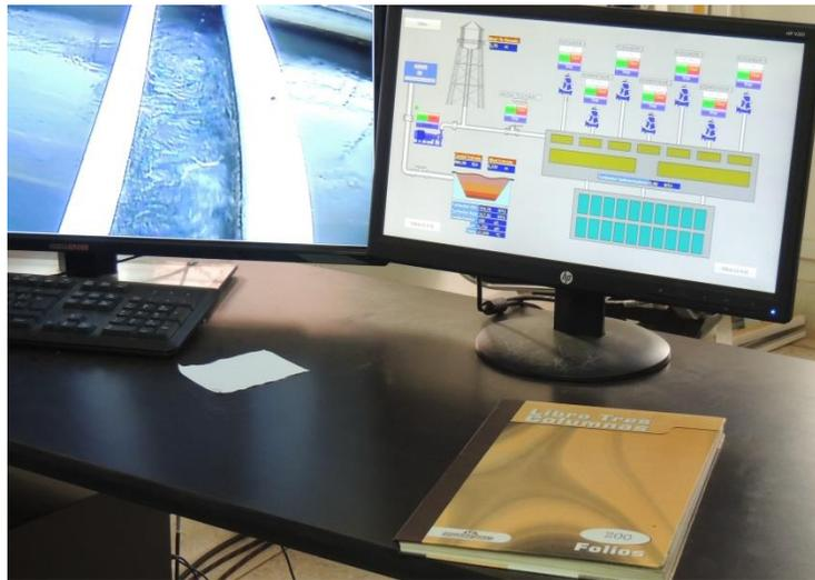
Figura 33. Monitoreo computarizado del proceso en tiempo real.
