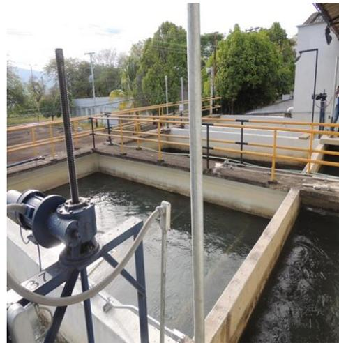
Figura 27. Tanque de Filtración durante el retro-lavado del filtro.
