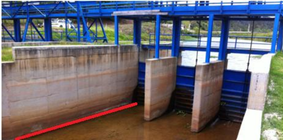
Figura 2. Fotografía de las Compuertas de Tolón. Elaboración propia.
