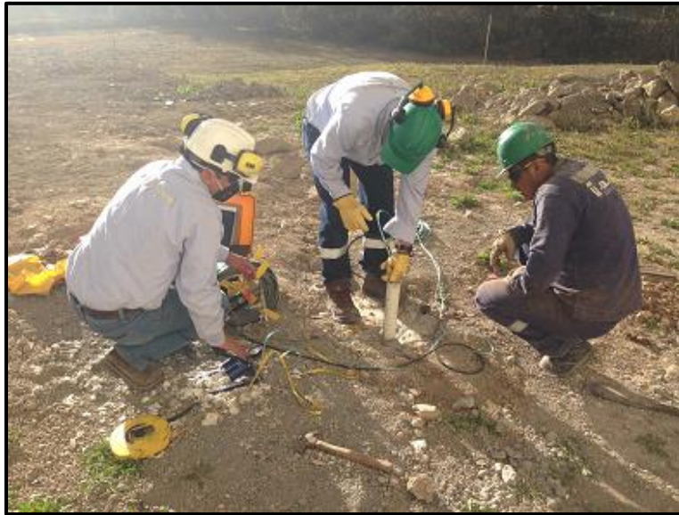
Figura 6. Captura de información durante la ejecución de Pruebas Downhole en las perforaciones ejecutadas previamente entubadas con tubería PVC. Fuente: Propia
