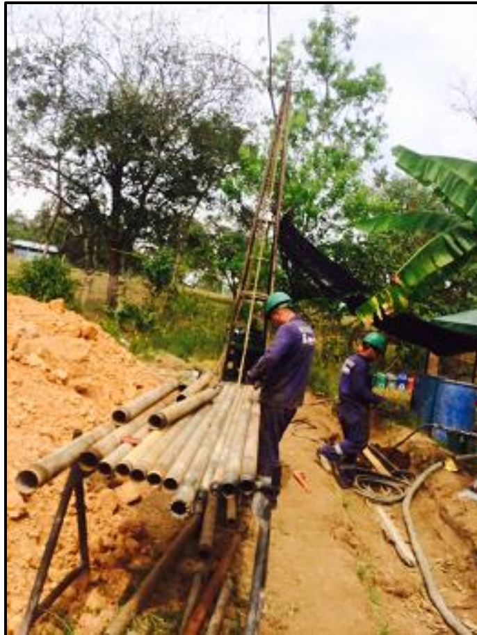
Figura 3 Extracción de muestreo de rocas areniscas sobre la Formación Arenisca Tierna coordenadas Norte = 1016846. Fuente Propia
