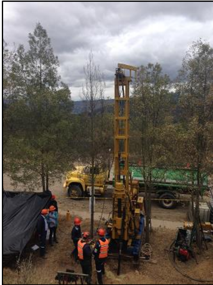
Figura 2. Extracción de muestreo de rocas calizas en la Formación Belencito Norte = 1119536, Este = 1135638. Fuente: Propia
