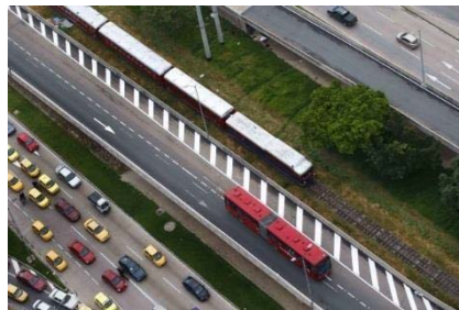
Ilustración 6 Vías para servicio Troncal- Tomada de: www.transmilenio.gov.co/es/articulos/infraestructura
