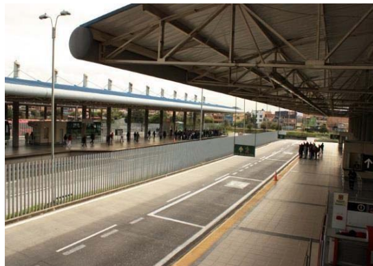
Ilustración 8 Estación cabecera del servicio troncal – Tomada de: www.transmilenio.gov.co/es/articulos/infraestructura
