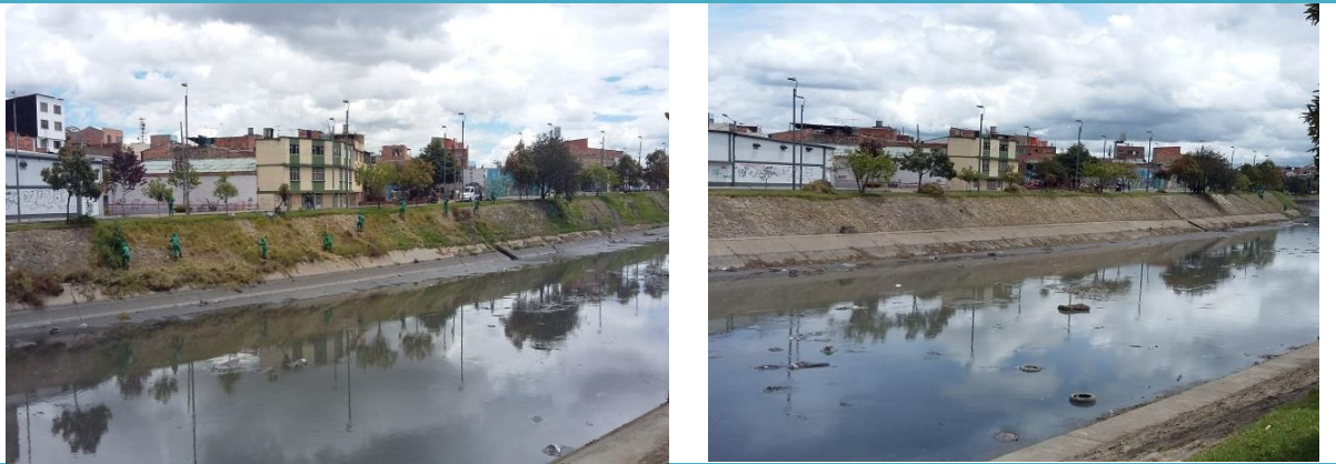
Figura. 3 Deshierbe de taludes Canal Salitre a la altura de la calle 80.
