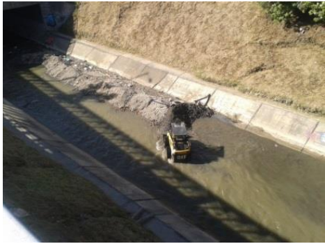
Figura. 4 Retiro mecánico de residuos solidos
