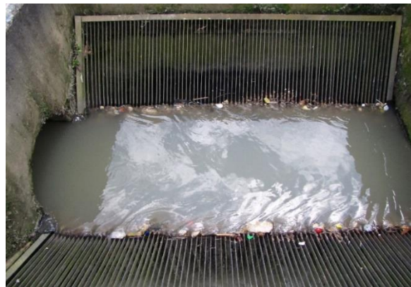
Foto 11. Estructura de control de caudales Desarenador 1
