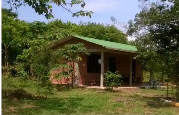
Foto 29. Caseta Operatoria y Laboratorio
