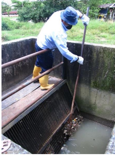
Foto 37. Rejillas de Cribado
