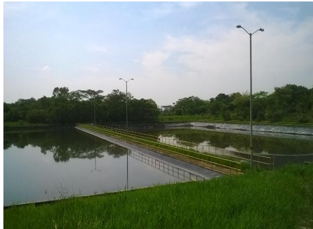
Foto 21. Lagunas de Maduración
