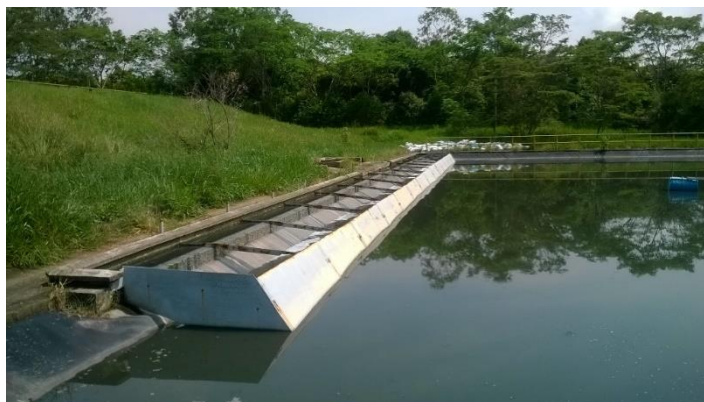
Foto 18. Canal de Entrada a las Lagunas
