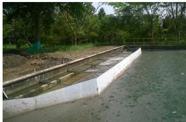
Foto 22. Canales de Entrada
