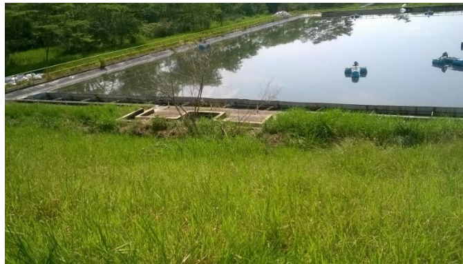
Foto 24. Sistema de Aireación Laguna de Maduración Norte, el cual se encuentra fuera de servicio
