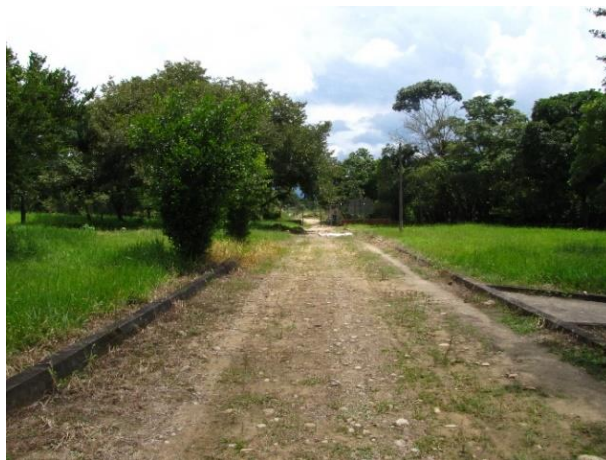
Foto 31. Caseta de Herramienta y Vía de Acceso a la PTAR
