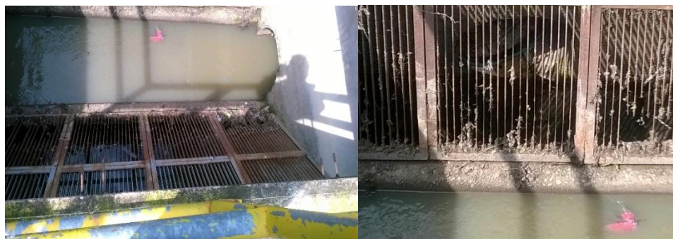
Foto 33. By-Pass Caudal de Excesos y Acumulación de Arenas
