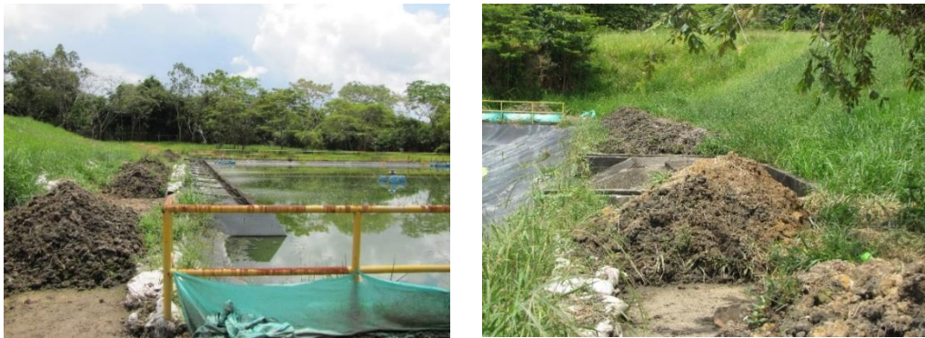
Foto 17. Estructura de Entrada a las Lagunas
