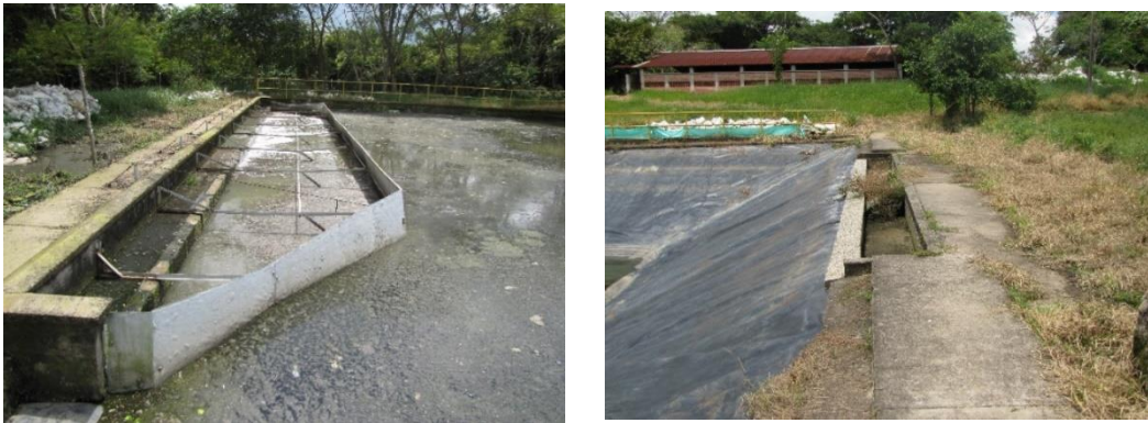
Foto 14. Canal de repartición, entrada del caudal proveniente del desarenador No.2
