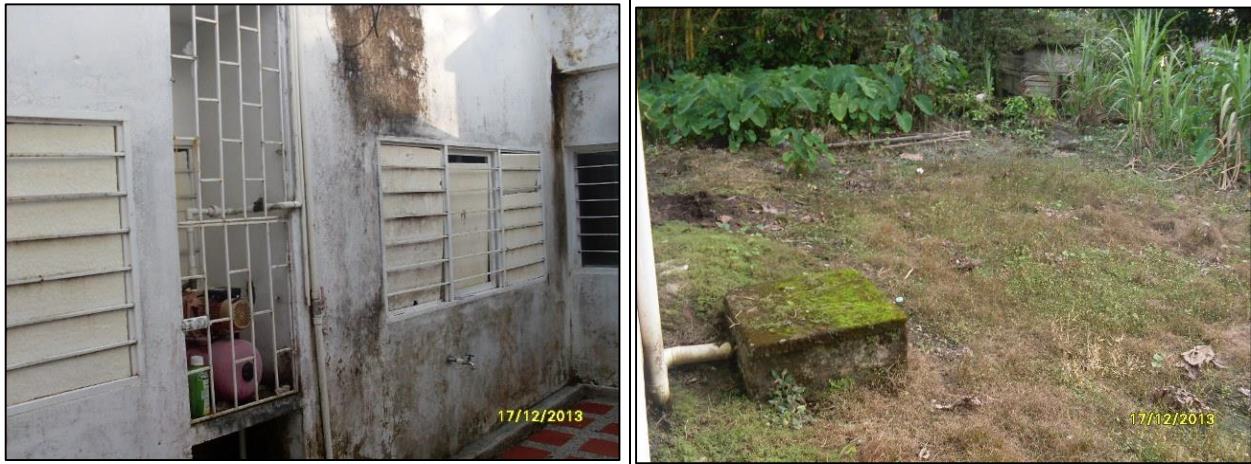
Ilustración 22 Patio interior y pozo séptico CS Palestina
