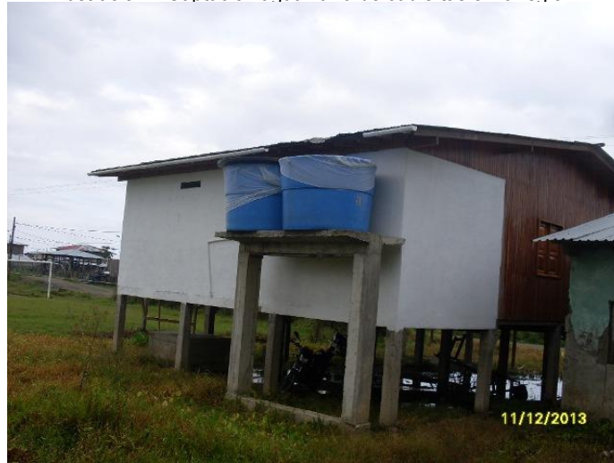
Ilustración 2 Captación agua lluvia de cubiertas en la región
