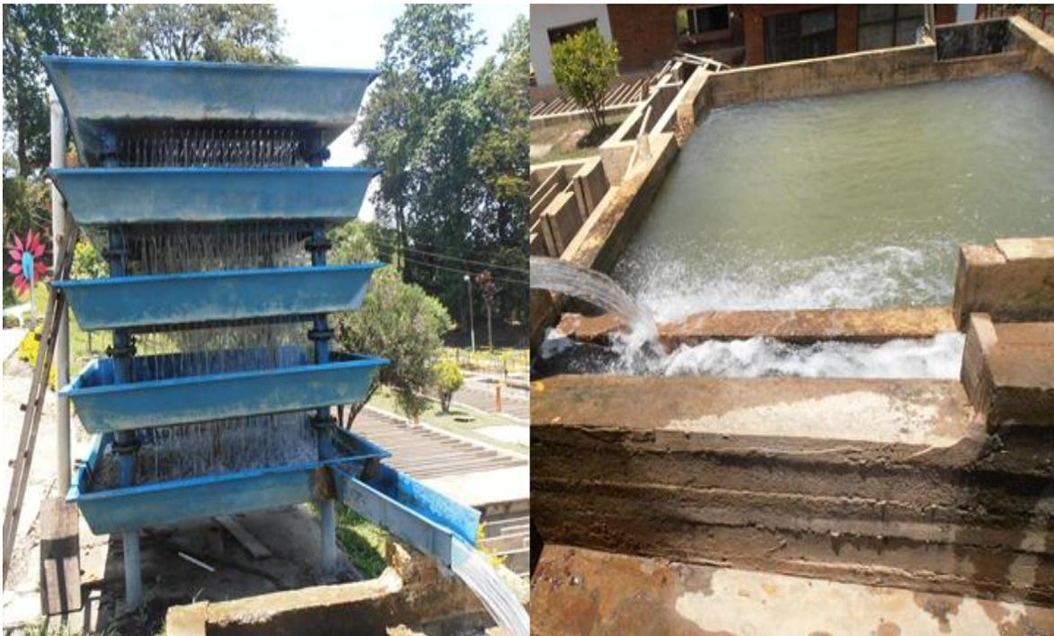
Figura 8. Torre de aireación y tanque de llegada
