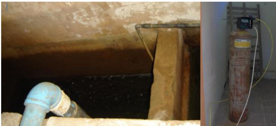
Figura 13. Tanque de contacto y cilindro de cloro
