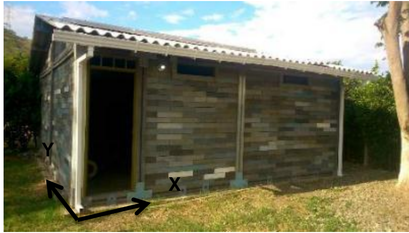
Figura 4-52: Sentido de aplicación de la fuerza del viento y sismo ilustrado en la vivienda de prPEAD a escala real. Fuente: Autor.
