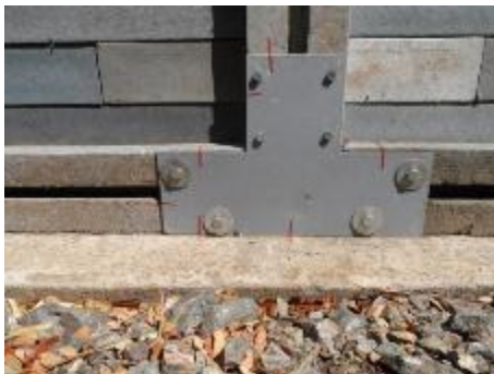
Figura 3-45: Marcas de referencia para medir desplazamientos locales. Fuente: Autor.
