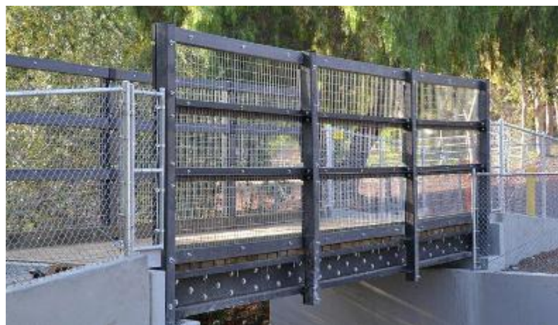
Figura 2-10: Conformación de un puente con elementos estructurales fabricados con plástico reciclado. Productos: Struxure ® Beans. Fuente: (31) (32) (33)
