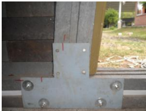
Figura 4-61: Rotación en columna 1-a en pórtico #1 durante ensayo de CARGA a estructura tipo vivienda a escala real. Fuente: Autor
