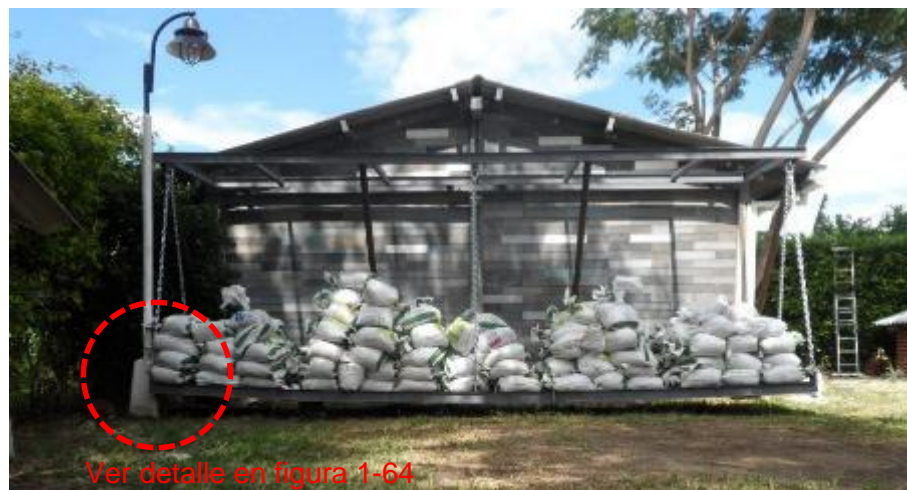
Figura 4-58: Estado de carga en montaje durante incremento de carga cinco (ciclo de carga 5) en ensayo a carga lateral estática en estructura a escala real. Fuente: Autor
