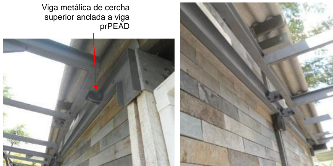
Figura 3-34: Montaje, unión de viga metálica de cercha superior a estructura a escala real. Fuente: Autor
