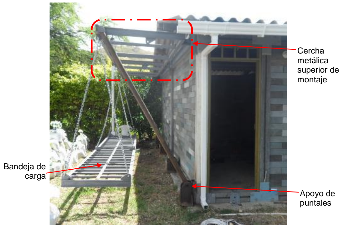
Figura 3-33: Montaje instalado en estructura a escala a escala real. Fuente: Autor
