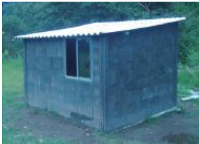
Figura 2-6: Módulo de vivienda construido. Fuente: (29).
