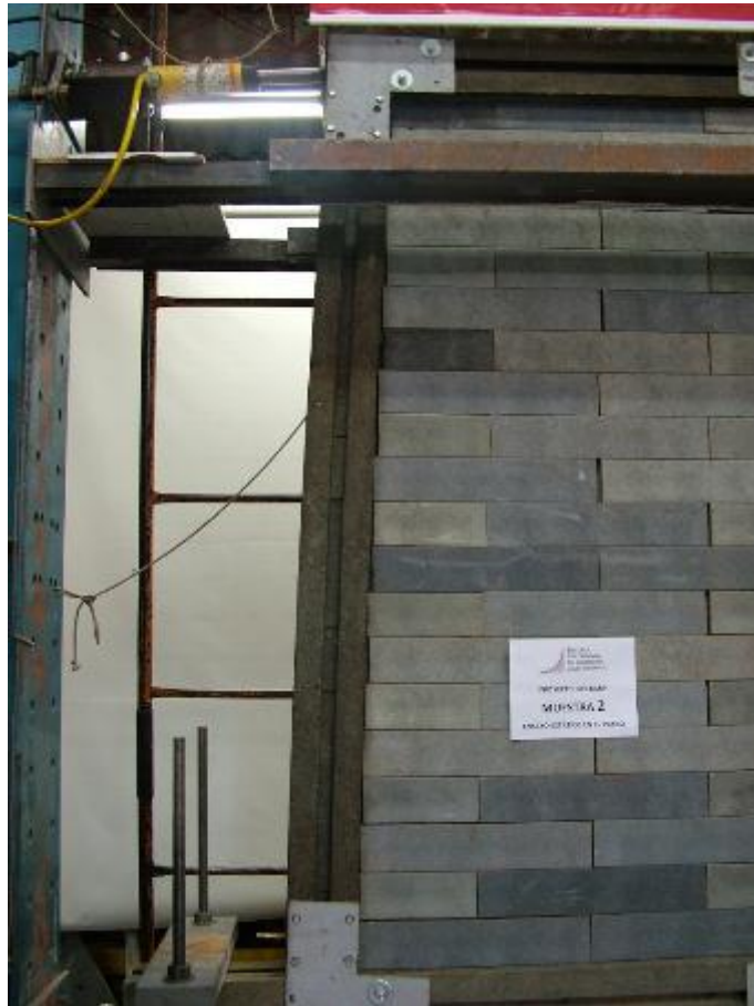
Figura 4-41: Desplazamiento de bloques individuales que conforman el muro, muro a escala real sometido a fuerza cortante. Muestra 2. Fuente: Autor.
