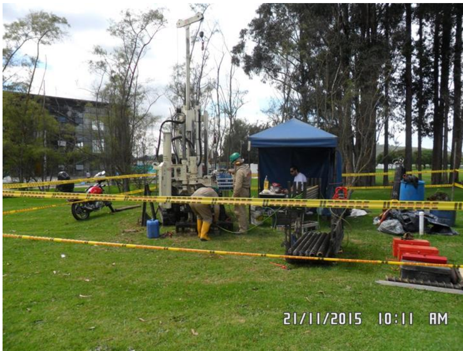
Fotografía No. 14. Prueba de campo SCPTu (IGR SAS). Fuente: Propia, 2016.
