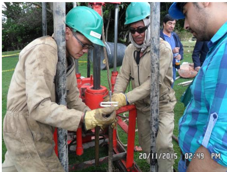
Fotografía No. 12. Perforación convencional – Ensayo veleta de campo (IGR SAS). Fuente: Propia, 2016.
