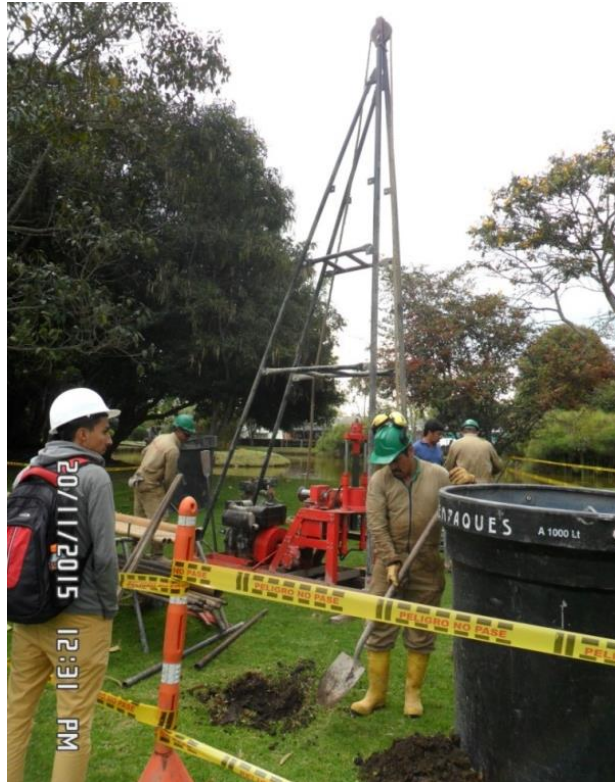
Fotografía No. 11. Perforación convencional (IGR SAS). Fuente: Propia, 2016.
