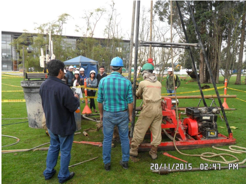
Fotografía No. 1. Perforación con equipo de percusión y lavado. Fuente: Propia, 2016.
