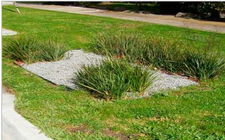
Figura 2. Pozo de Infiltración (García Haba, 2011, p. 63)
