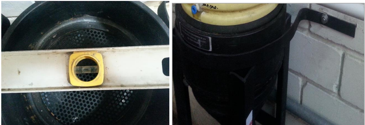
Figura 75. Nivelación y Sujeción del soporte y Tubo a la Pared
