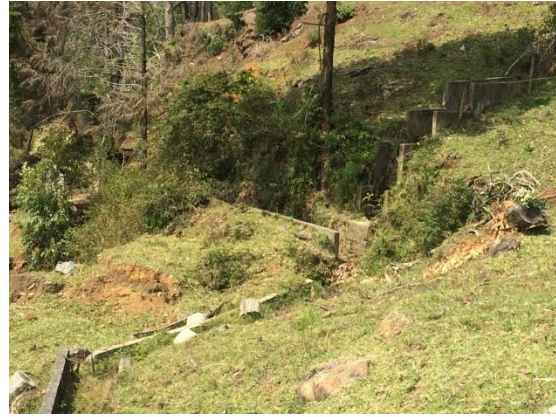
Acercamiento a escarpe costado Occidental
