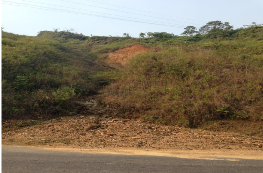
Figura 16. Detritos transportados desde la parte alta del talud, desintegración de la roca.
