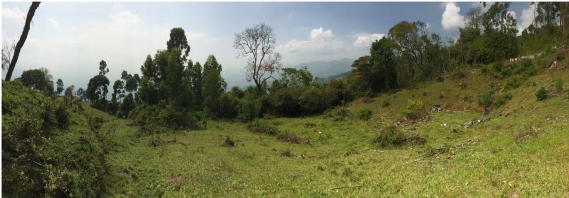
Figura 62. Panorámica del deslizamiento desde un punto medio hacia el sur (parte baja).
