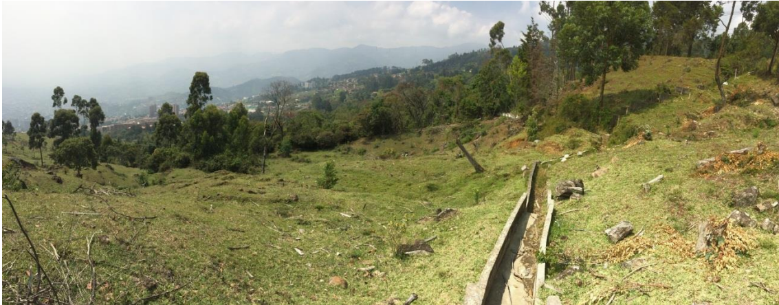
Figura 60. Panorámica del deslizamiento desde la parte alta hacia el sur (parte baja).
