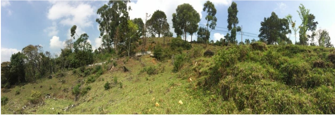
Figura 61. Panorámica del deslizamiento desde un punto medio hacia el norte (parte alta).
