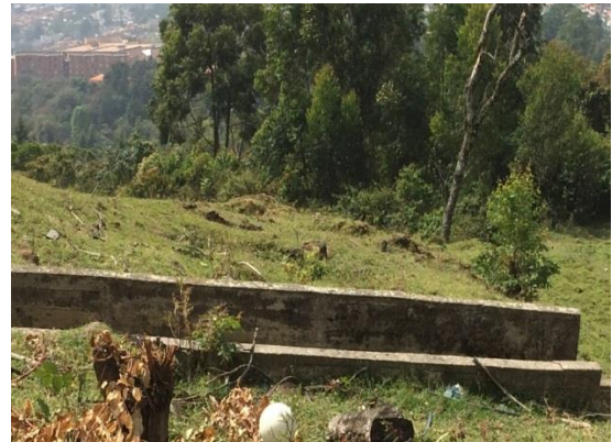
Acercamiento a escarpe costado Oriental
