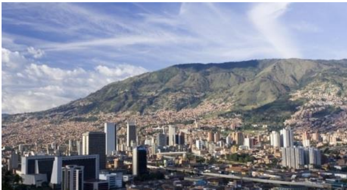
Figura 1. Valle de Aburra, crecimiento de la construcción. Fuente: Alcaldía de Medellín (2011) Estabilidad de las laderas en el valle de Aburra Medellín - ladera suroriental
