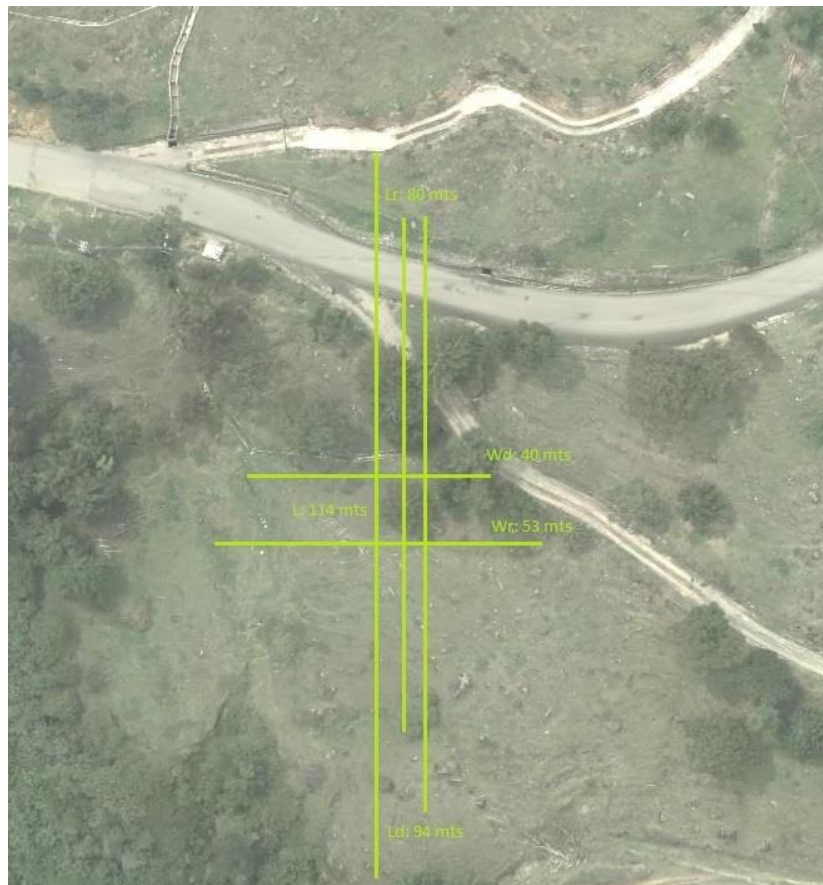
Figura 66. Medidas del deslizamiento Fuente: Elaboración Propia.
