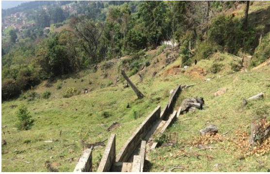
Inclinación se tronco
