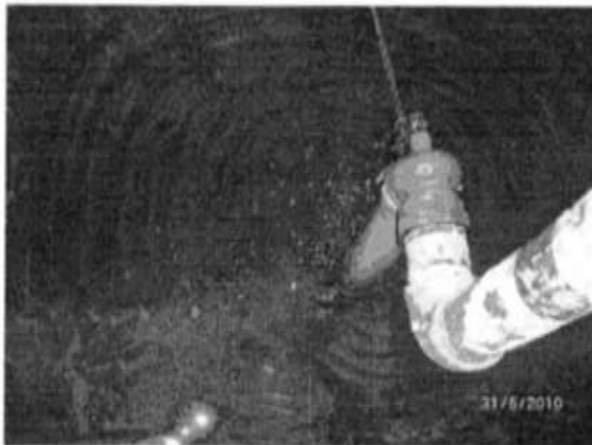
5. INTERIOR TANQUE DE RESERVA
