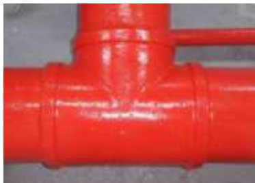
Imagen 13. Unión roscada.
