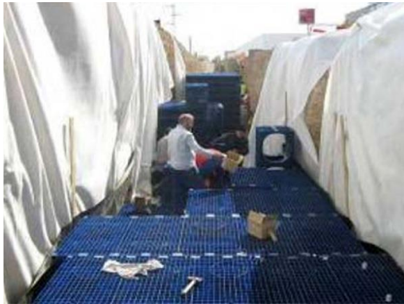
Imagen 10. Depósito de detención enterrado
