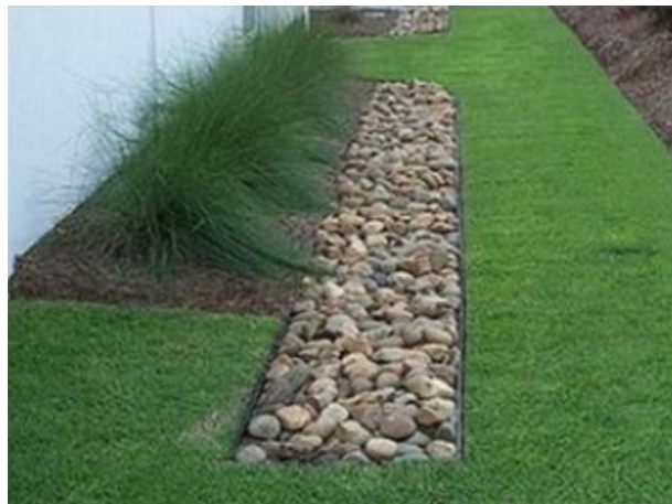
Imagen 5. Zanja de infiltración
