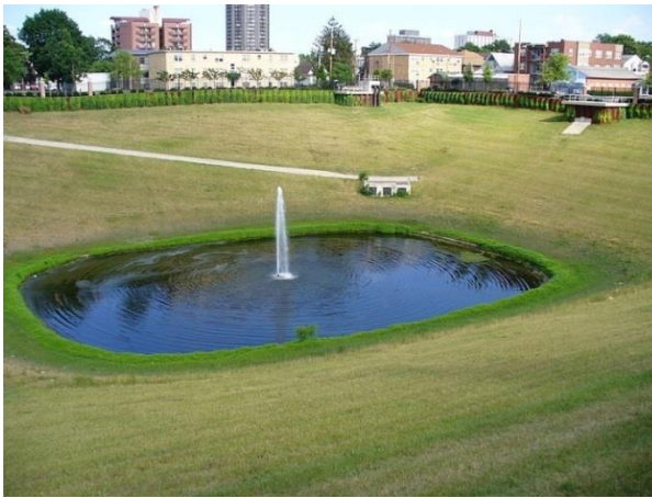
Imagen 9. Depósito de detención en superficie
