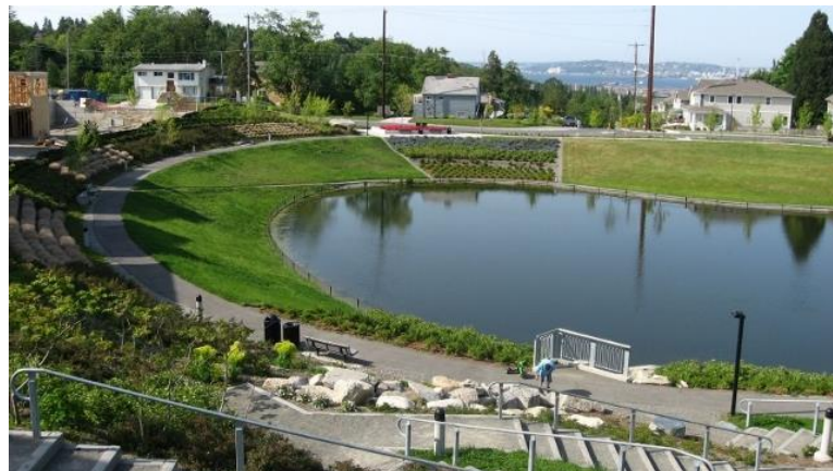
Imagen 11. Estanque de retención
