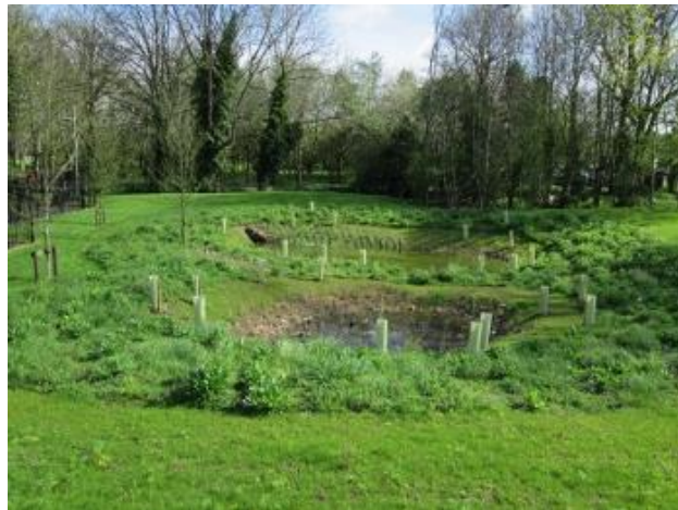
Imagen 8. Depósito de infiltración
