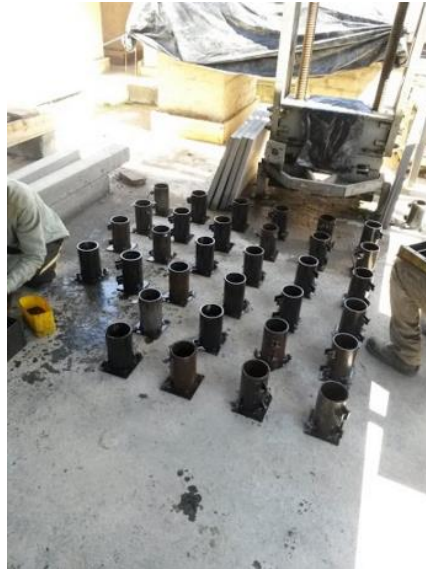
Figura 4 Preparación de formaletas para fundida
