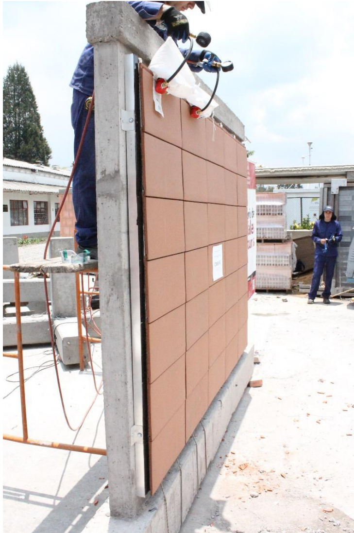
Fotografía 7-57 Montaje e instrumentación del muro C10-S-FA
