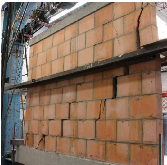
(a) Falla escalonada en muros de mampostería
