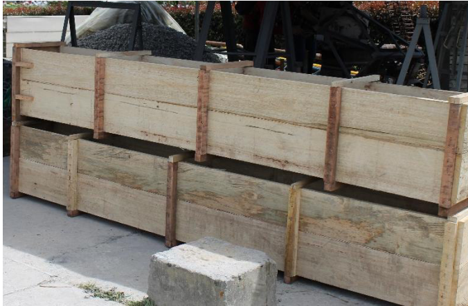
(a) Armado de formaletas
