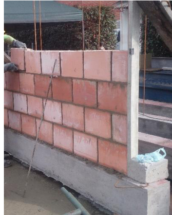
(d) Traba adecuada en los muros
