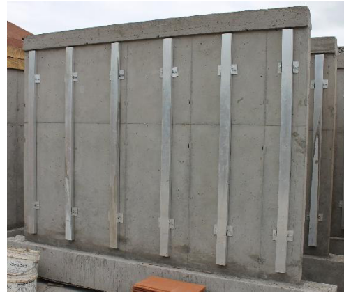
(a) Se instalan los perfiles tipo boquilla en los muros
