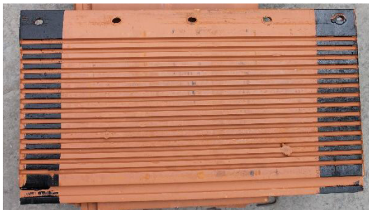
(b) Se aplica el Sika Aktivator, se deja secar y seguidamente el Sika Primer 206, que se deja secar por 20 min.
