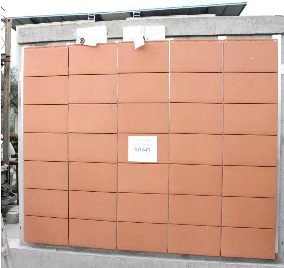
Fotografía 7-59 Montaje e instrumentación del muro C12-S-FT
