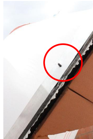
(b) Falla del perfil de soporte
