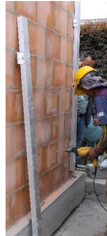
(b) Se perfora el muro para anclar los ángulos
