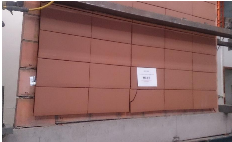
(a) Falla en la base del muro y detalle de falla del elemento de fachada
