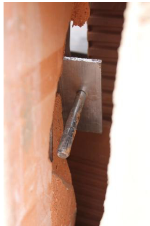
(e) Falla del anclaje del sistema de fachada al muro
