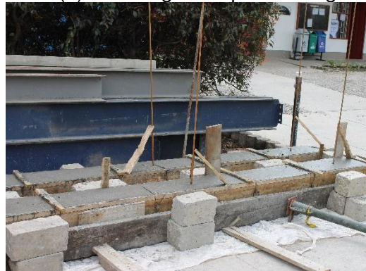
(d) Colocación y vibrado del concreto.
