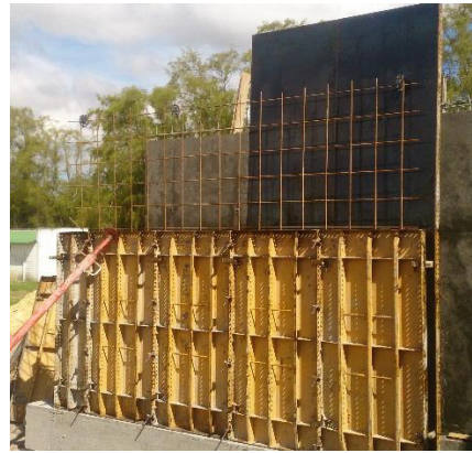
(b) Armado de la formaleta sobre la viga de cimentación
