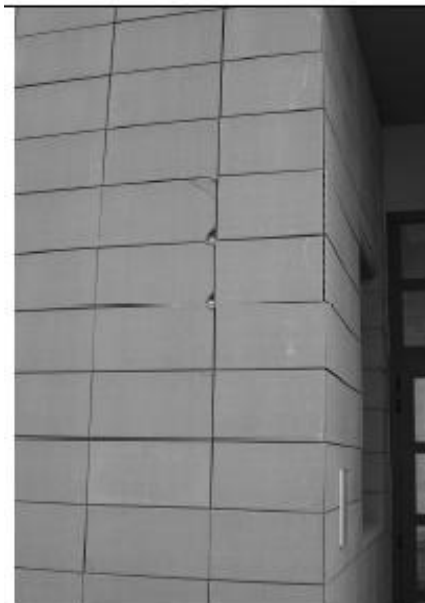
Fotografía 2-4 Vista de la fachada ventilada de un edificio público ubicado en L'Aquila (Italy) después del sismo.
