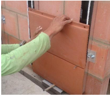
(f) Se acomodan las piezas de fachada ventilada Santafé
