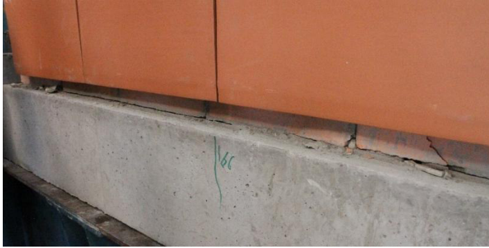
(a) Fisuras en la base del muro
