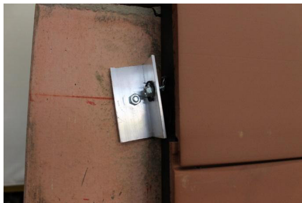
(f) Desplazamiento del perfil de soporte
