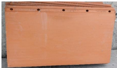
(d) Se preparan las piezas de fachada a instalar
