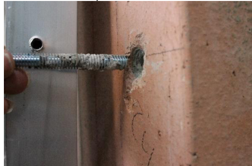
(d) Desplazamiento relativo de piezas de fachada
