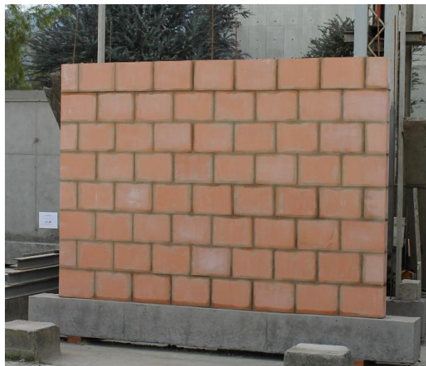
(e) Muro al terminar su construcción
