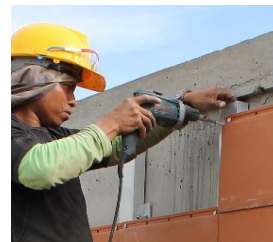
(e) Se conectan las piezas de fachada a los perfiles utilizando tornillos autopercutores.
