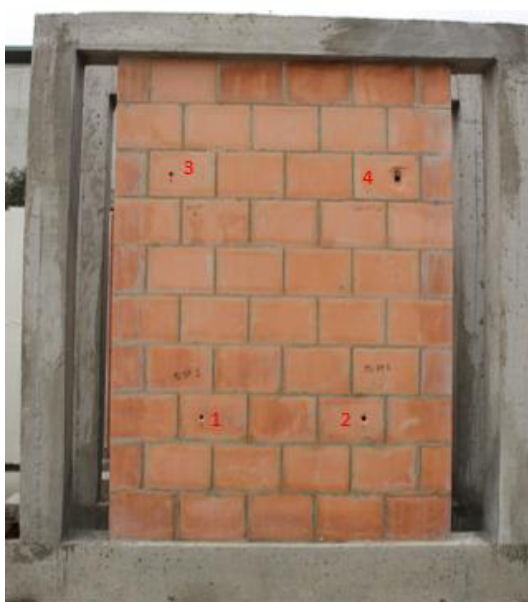
Fotografía 5-12 Numeración de anclajes en muros de ensayo Fuente: El autor
