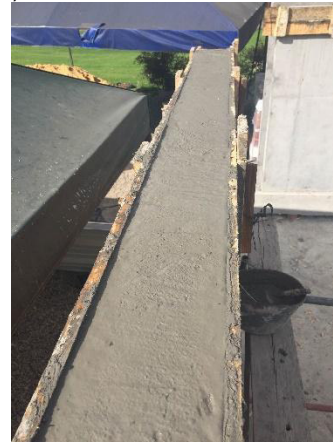
(d) Viga después del terminado final
