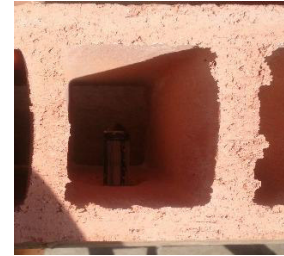
(b) Se coloca el tamiz dentro de la perforación después de limpiar la perforación
