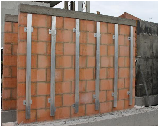
(a) Se instalan los perfiles tipo boquilla en los muros
