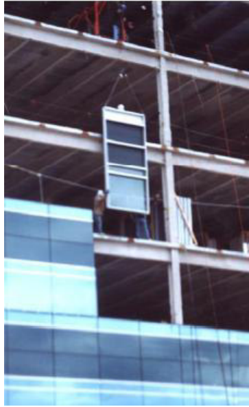
Fotografía 1-7 Instalación de muro cortina con piezas de vidrio
