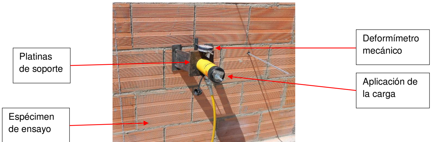
Fotografía 4-23 Montaje de ensayo de extracción de anclajes químicos
