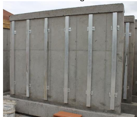
(b) Se perfora el muro para anclar los ángulos
