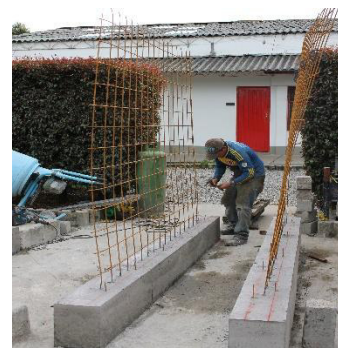
(f) Desencofrado de vigas para muros de concreto
