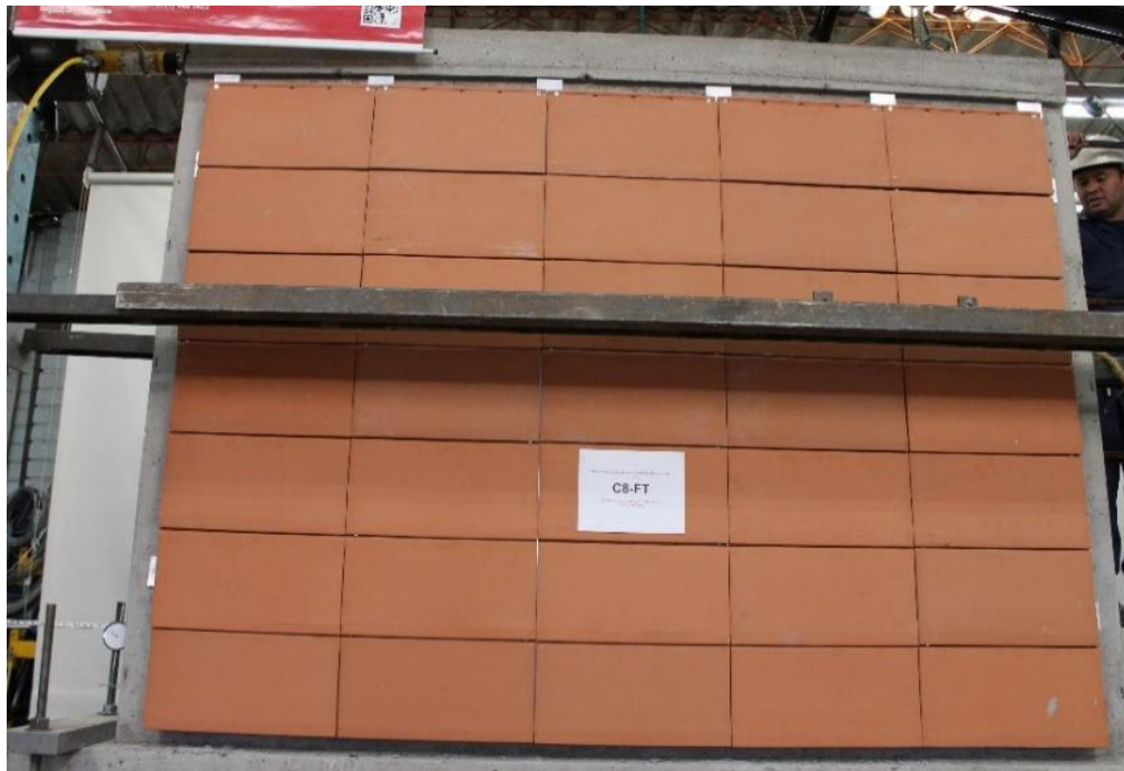
Fotografía 7-23 Montaje e instrumentación del muro C8-FT
