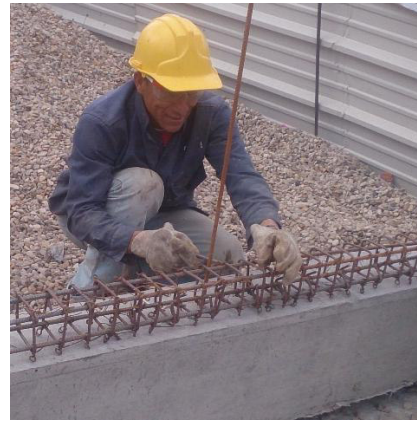
(b) Armado de acero de refuerzo
