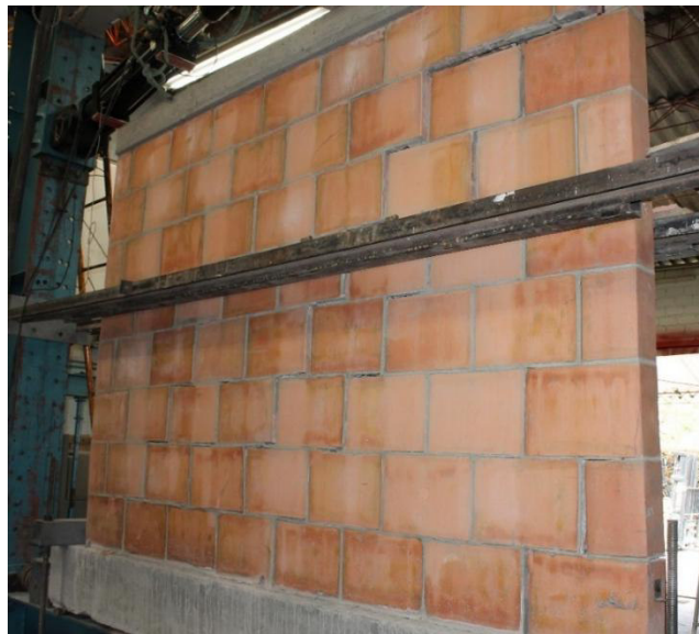
(b) Falla escalonada en la cara posterior del muro
