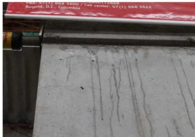
(b) Fisura en la parte superior del muro
