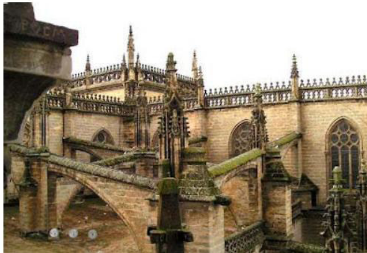
Fotografía 1-2 Detalle de la Catedral de Sevilla
