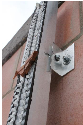
(b) Desplazamiento del perfil de soporte
