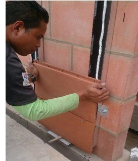
(g) Se adhieren las piezas de fachada ventilada Santafé
