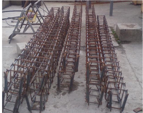
(b) Acero figurado para las vigas
