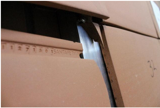
(c) Falla en la conexión de la pieza de fachada al perfil.
