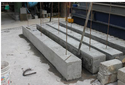
(e) Desencofrado de vigas para muros de mampostería
