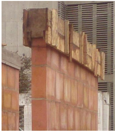
(a) Instalación de la formaleta en la parte superior del muro
