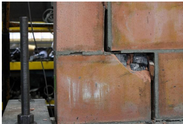
(a) Falla en el muro en la zona de tensión y compresión alternadas
