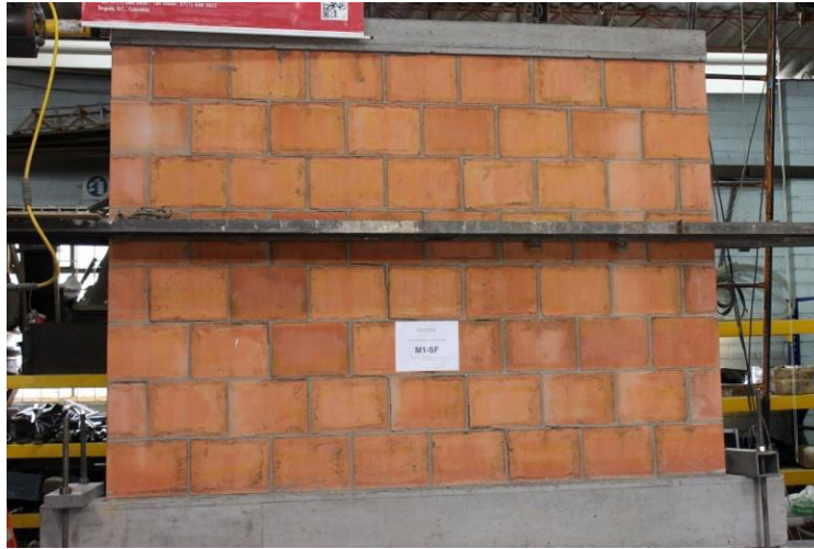
(a) Detalle falla escalonada en la cara frontal del muro
