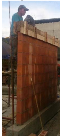
(a) Instalación de la formaleta en la parte superior del muro
