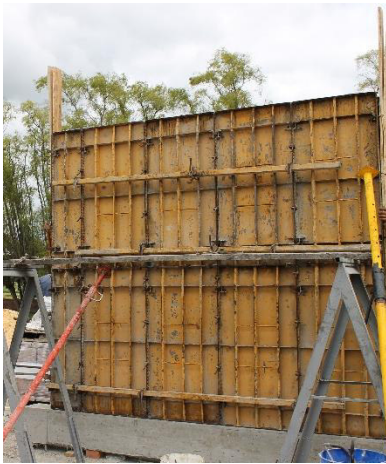
(c) Vertido del concreto y se realiza el vibrado correspondiente
