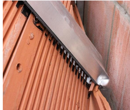
(f) Estrangulamiento del perfil de soporte
