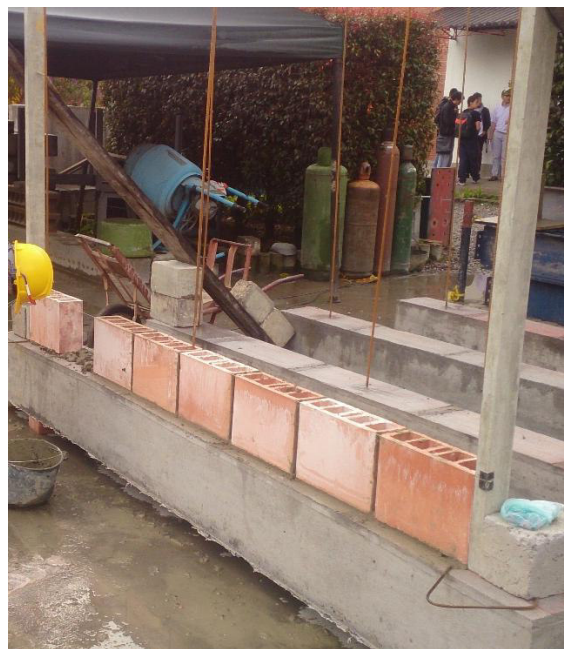
(b) Primera hilada de ladrillos con uno de guía en cada extremo
