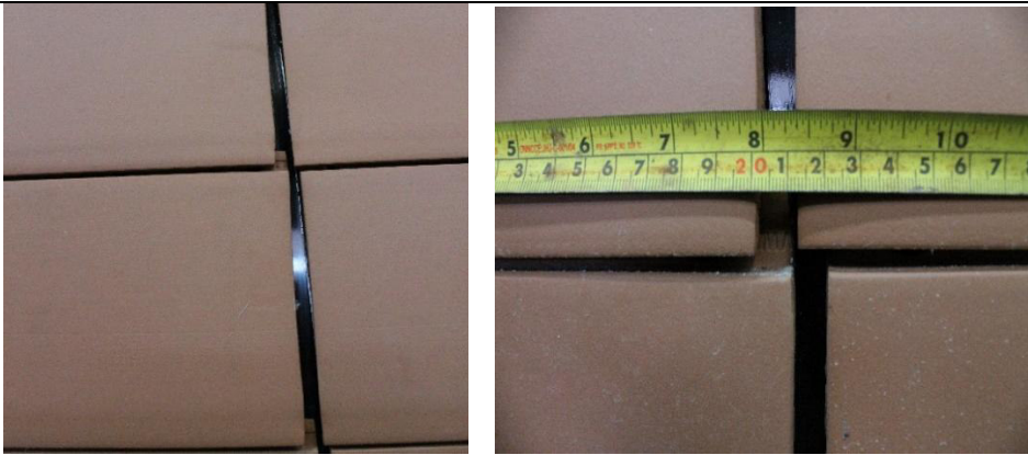
(c) Desplazamientos relativos de las piezas de fachada ventilada
