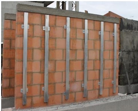
(a) Se realiza la conexión del ángulo de anclaje al perfil de soporte de la fachada
