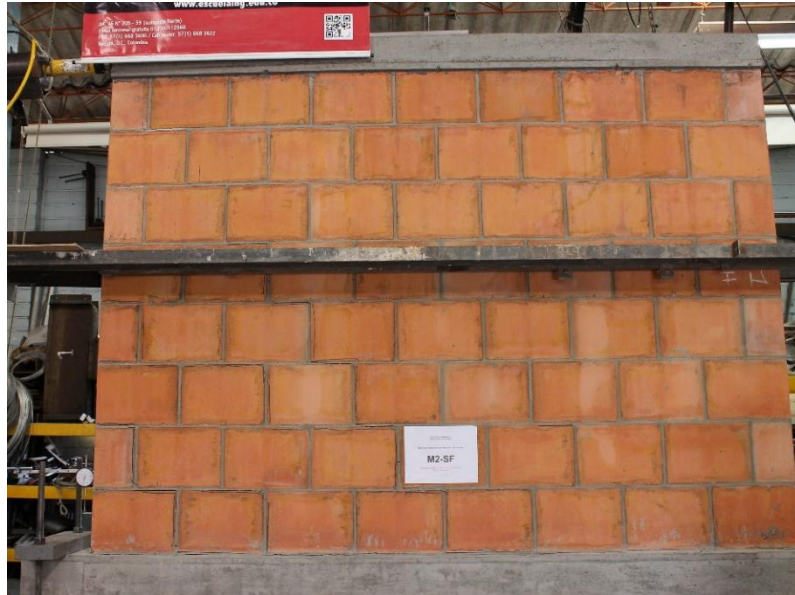
(a) Escalonamiento en la cara frontal del muro
