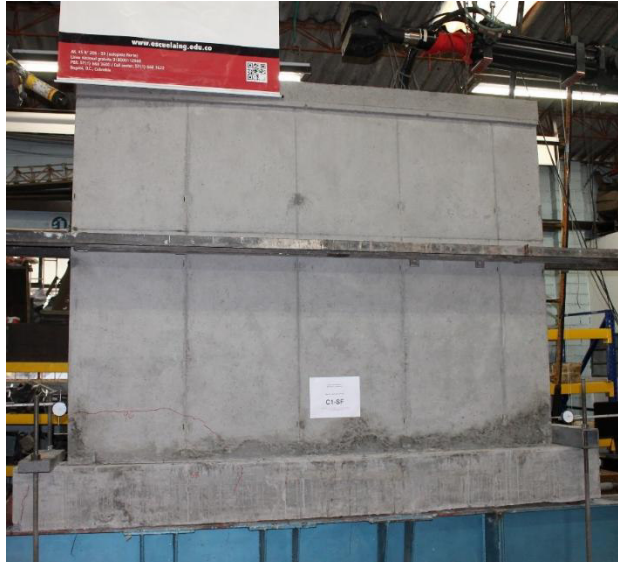
(a) Fisura en la base del muro
