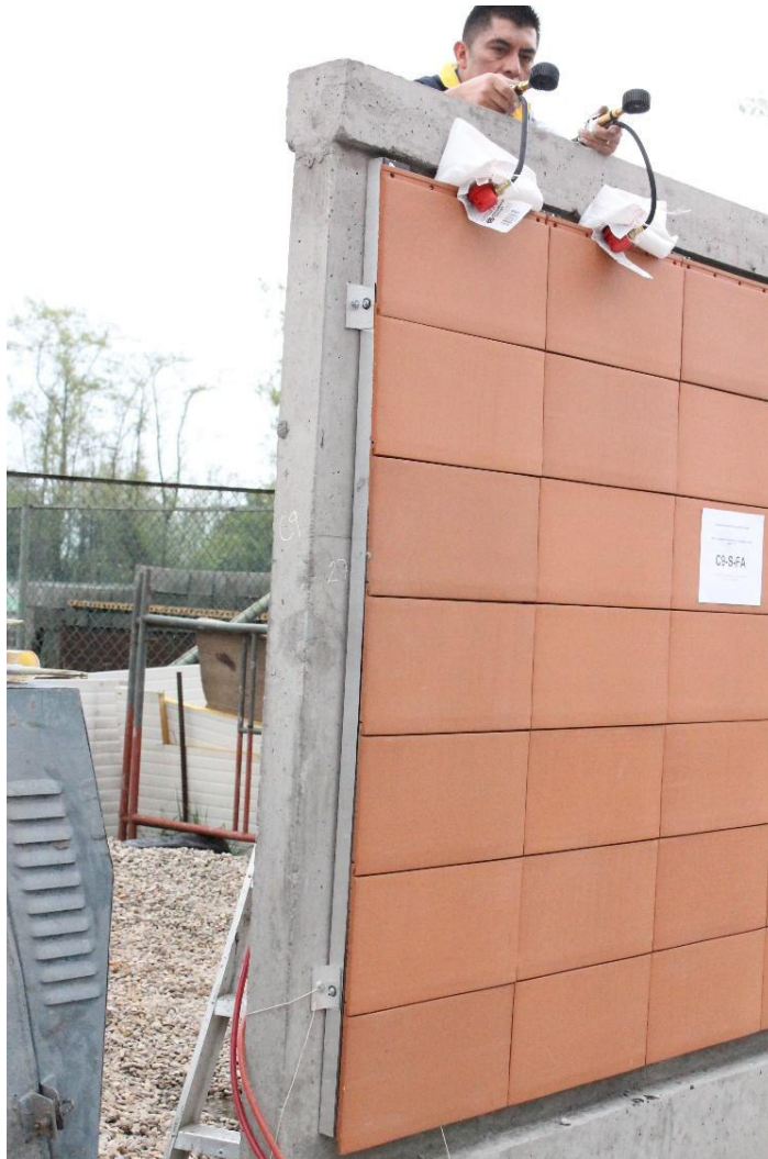
Fotografía 7-55 Montaje e instrumentación del muro C9-S-FA
