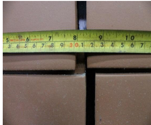
(d) Desplazamiento relativo de piezas de fachada
