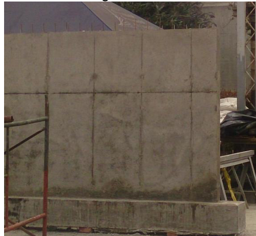
(d) Muro al terminar su construcción
