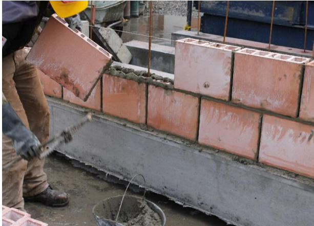
(c) Se aplica mortero y se coloca la siguiente hilada
