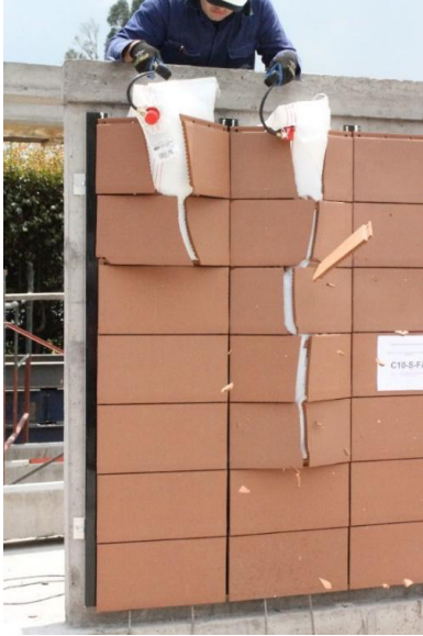
(a) Falla de la fachada cuando es adherida con poliuretano.
