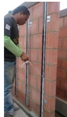
(e) Se retira la capa protectora de la cinta adhesiva
