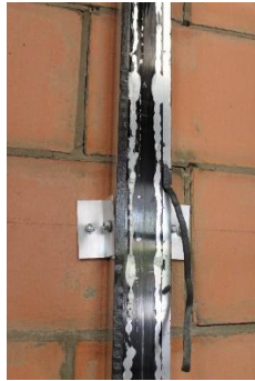
(c) Falla en la conexión de la pieza de fachada al perfil.
