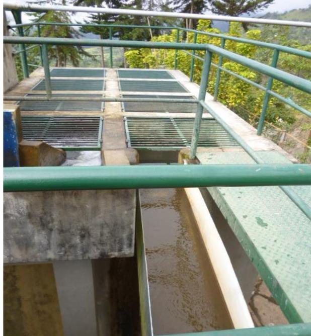
Imagen 9 Sedimentador alta tasa tipo panel
