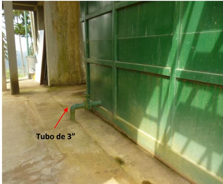
*Imagen 11 Evacuación de Lodos Sedimentador*
