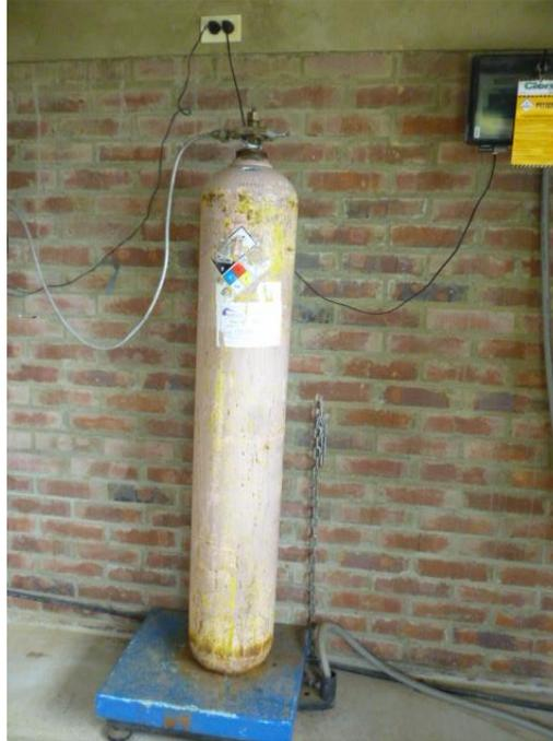
Imagen 17 Dosificación de Cloro Gaseoso al tanque de almacenamiento
