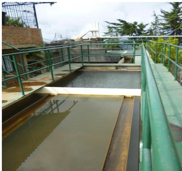
*Imagen 10 Evacuación de Lodos Sedimentador*
