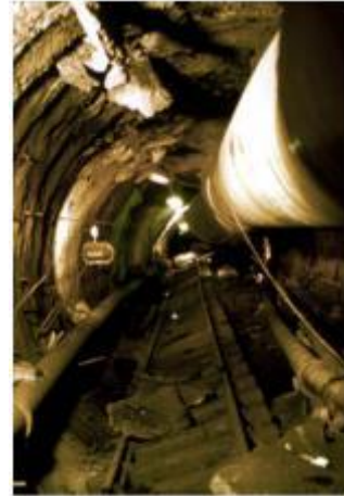
Figura 10-11. Levantamiento del suelo a unos 100 m por detrás de la unidad motriz TBM en 1979 a una cobertura de 400 a 425 m . Fuente: (E. Hoek & Guevara, 2009a)
