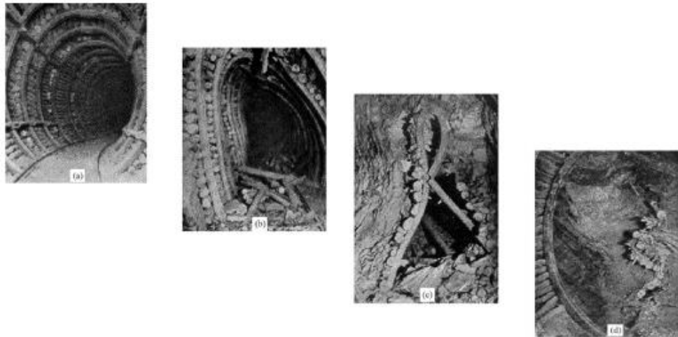
Figura 3-17. Desarrollo del squeezing en un túnel minero en la India. Fuente: (Gutiérrez R., 2015e)
