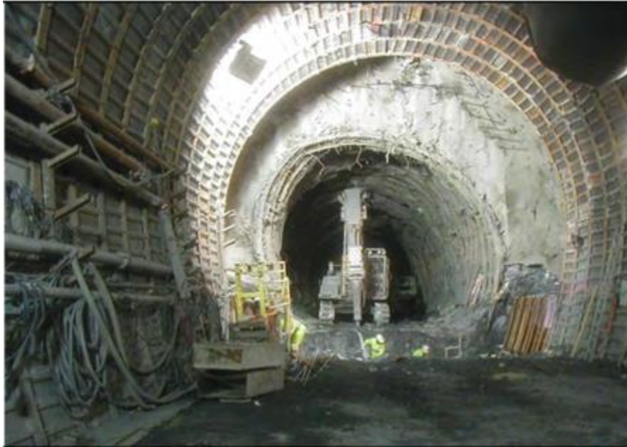
Figura 8-1. Fenómeno de Squeezing. Fuente: (Quispe Aronés, 2012)
