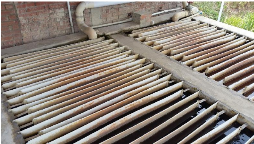
Fotografía 8 Tabiques horizontales acrílicos para flujo horizontal.
