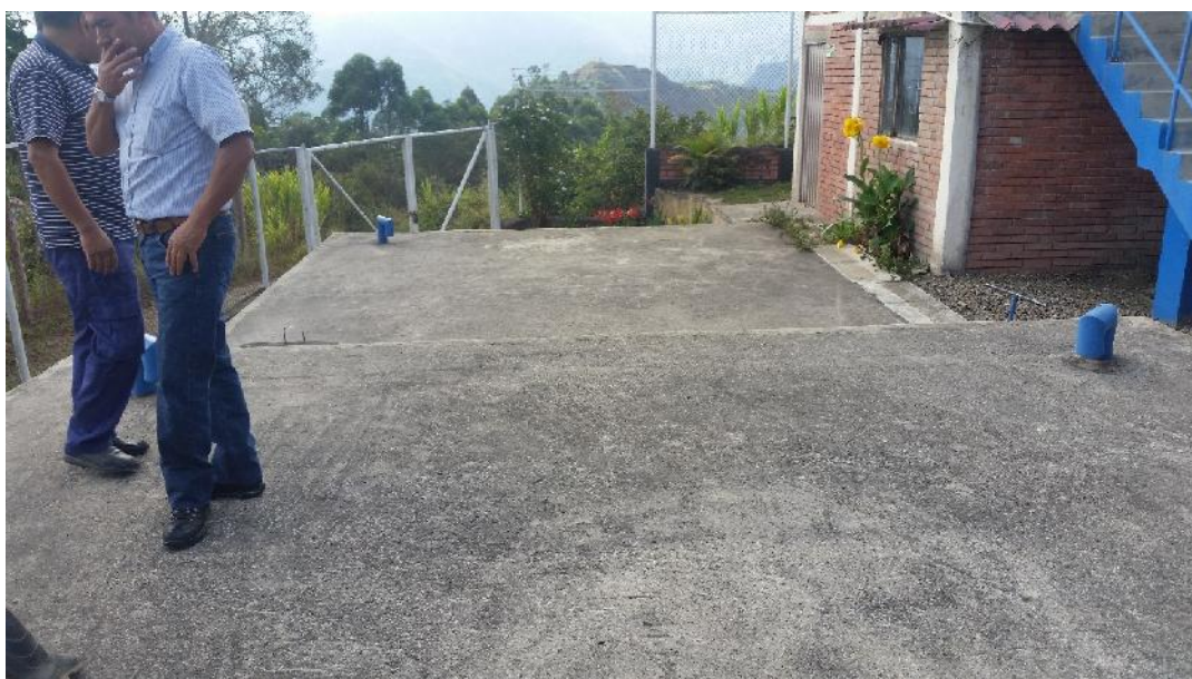
Fotografía 15 Tanques 1 y 2 de Almacenamiento de 70 y 50 Metros Cúbicos.
