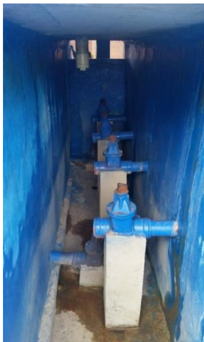
Fotografía 14. Válvulas de lavado en la parte baja de los filtros de flujo descendente, descarga abierta.
