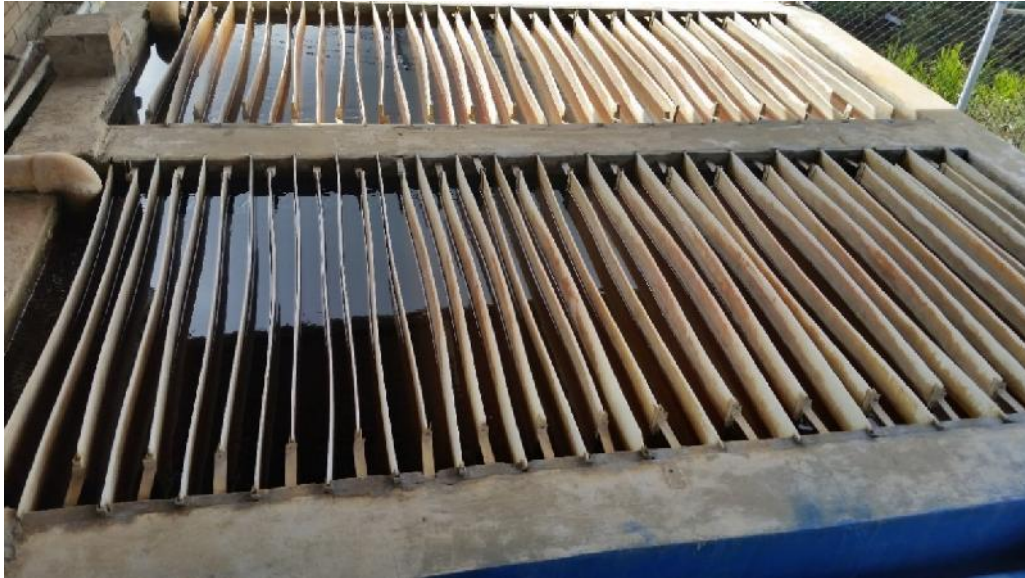
Fotografía 7 Estado Actual Floculadores Hidráulicos Horizontales
