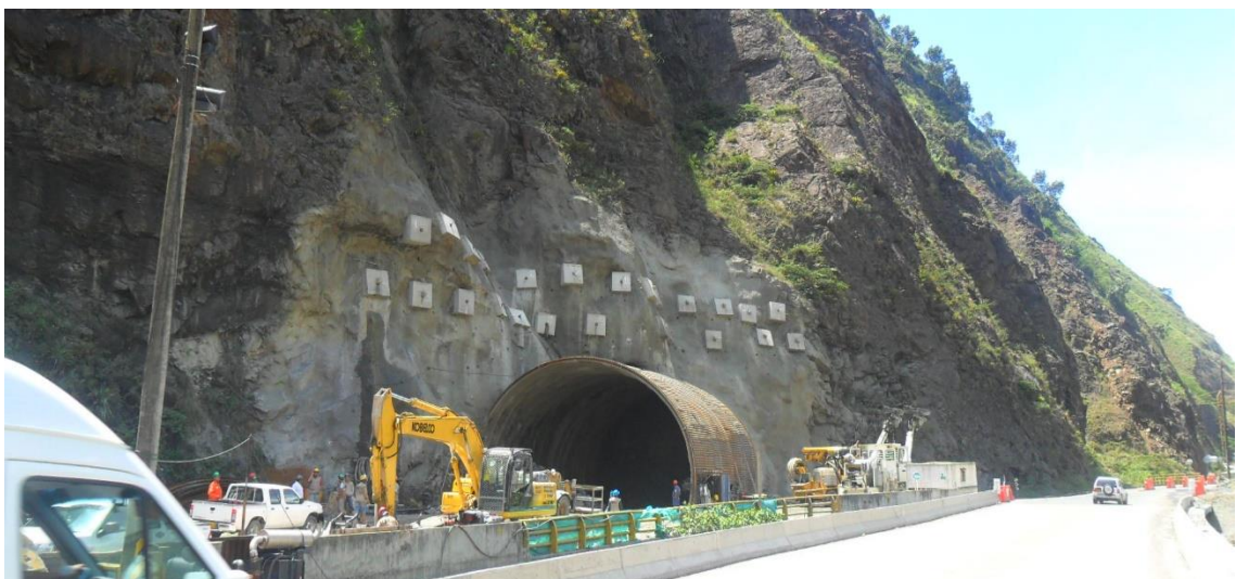
Figura 186 Inicio de la excavación del túnel (Estabilización y excavación del portal finalizadas)
