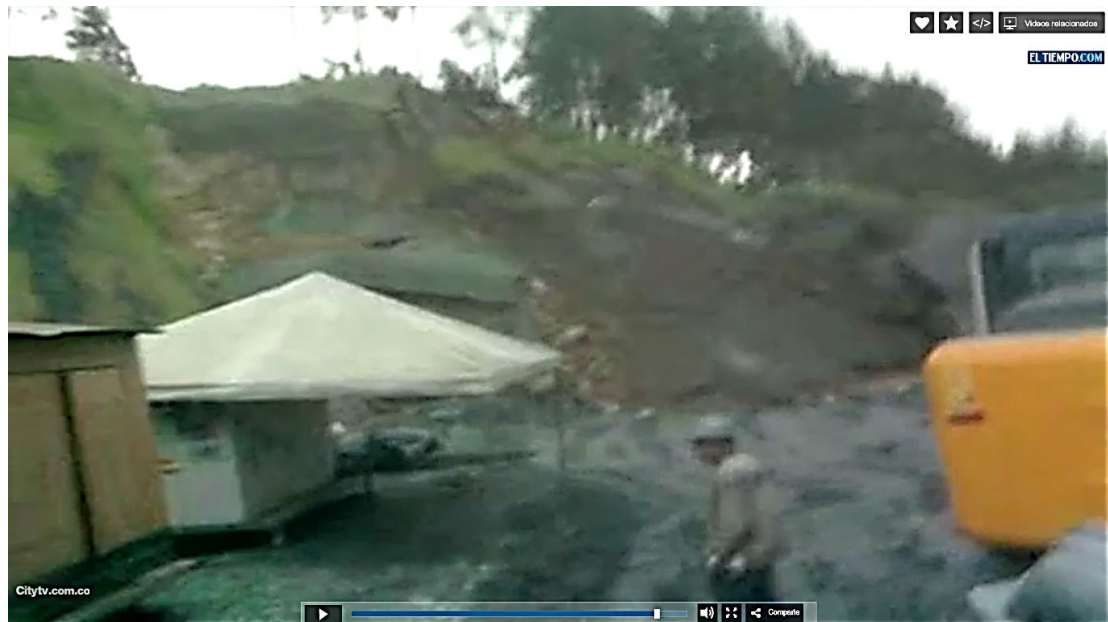
Figura 86 Etapa 3 Colapso del portal.
