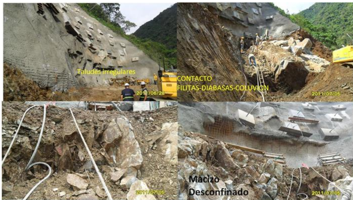
Figura 35 Construcción del talud lateral Coluvión-Diabasas
