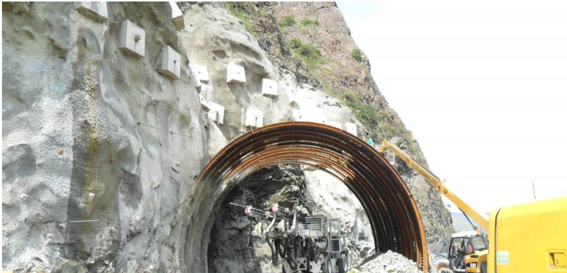
Figura 184 Avance de excavación del portal sesgado.
