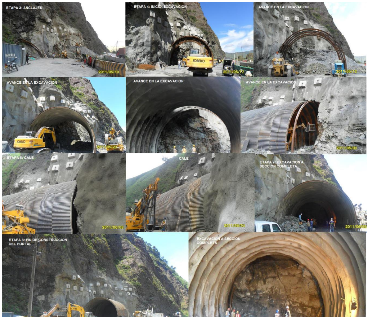
Figura 72 Secuencia constructiva portal entrada túnel 11 izquierdo.
