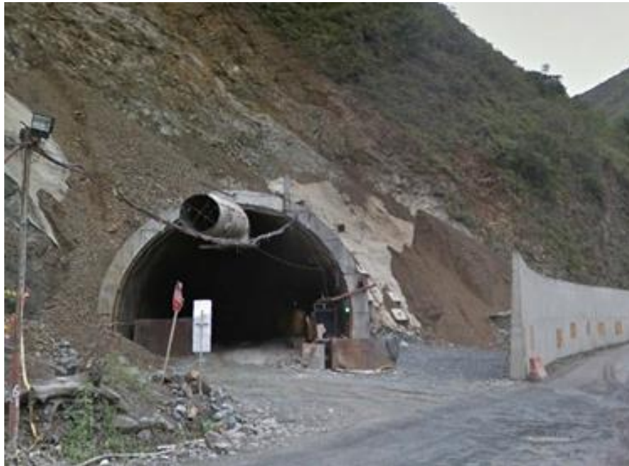
Figura 52 Solución final para el portal entrada túnel 10.
