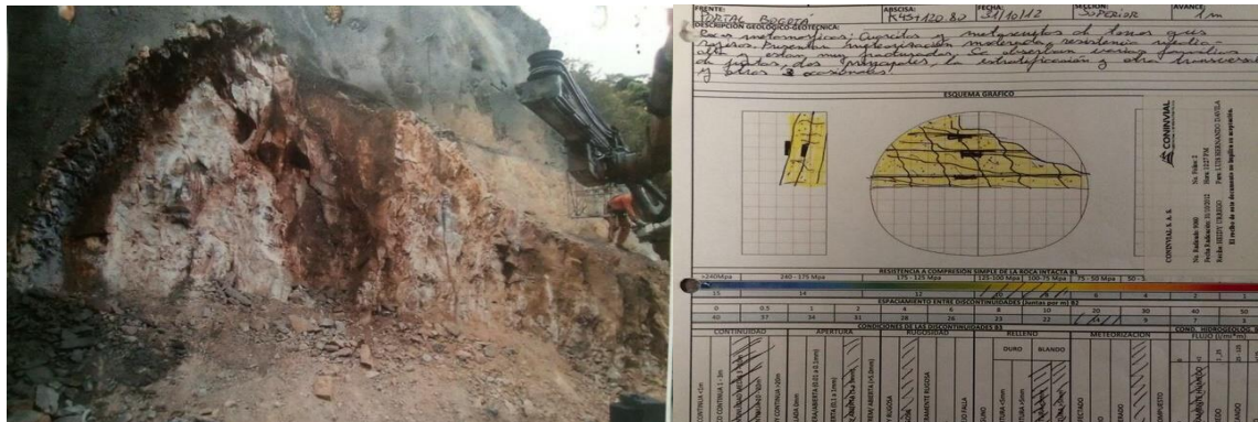
Figura 60 Sección K45+120.80 e interpretación geológica. (Fuente Concesionaria Coviandes)
