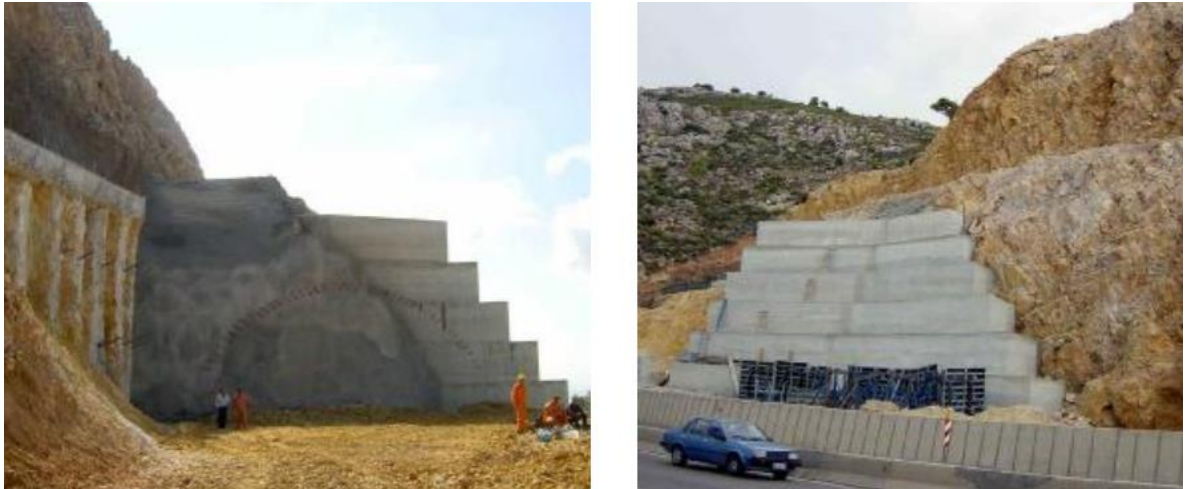
Figura 82 Construcción del portal entrada o este.
