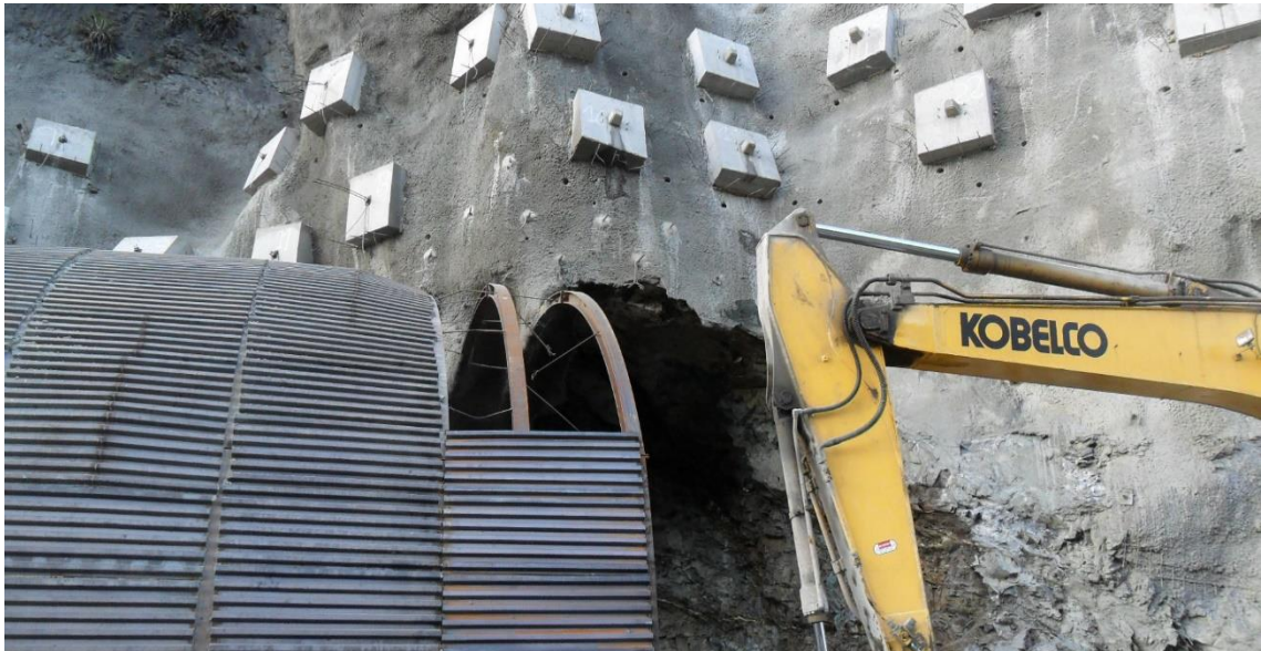
Figura 185 Final de la excavación del portal sesgado.
