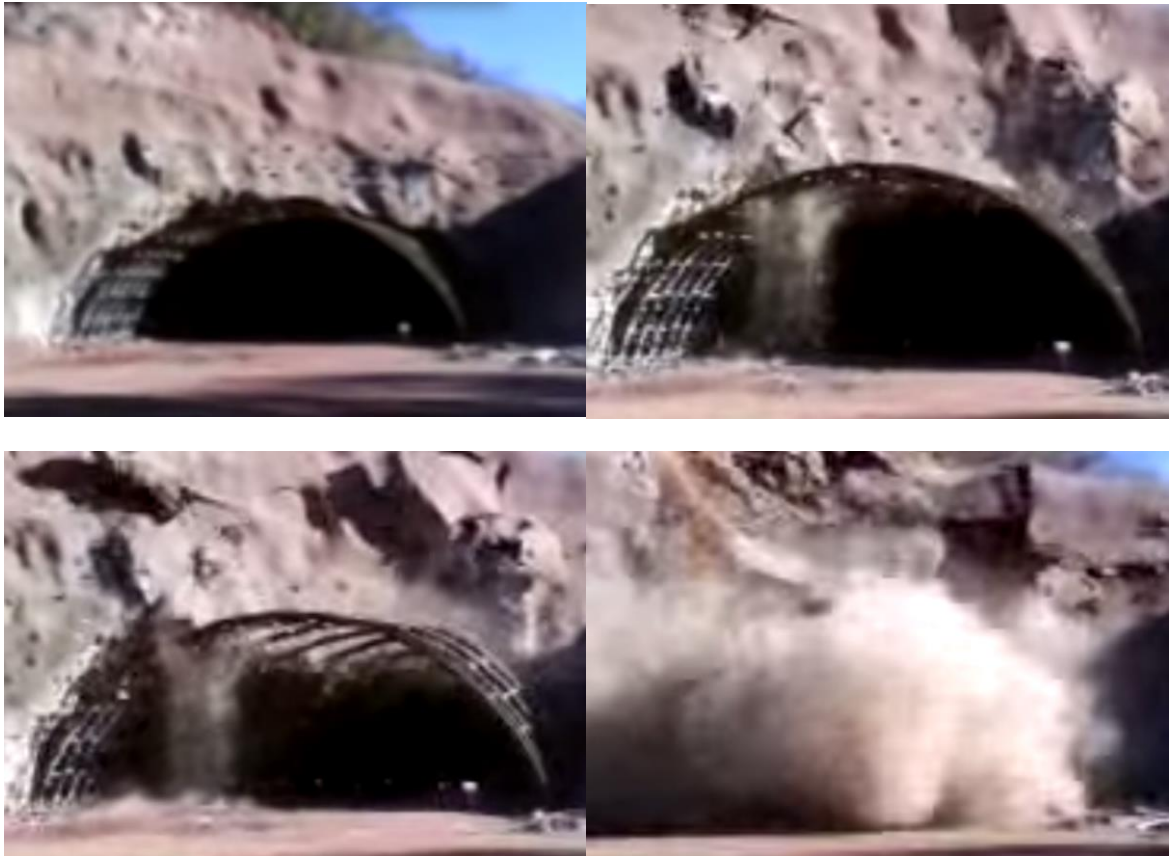
Figura 88 Secuencia de colapso del portal del túnel Varal (You Tube, 2010)
