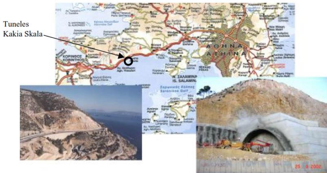
Figura 76 Localización general de los túneles Kakia Skala ( Koronakis, et al., 2002)
