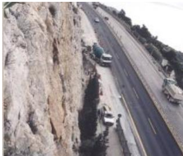
Figura 77 Morfología extremadamente empinada en la zona de los túneles de Kakia Skala.
