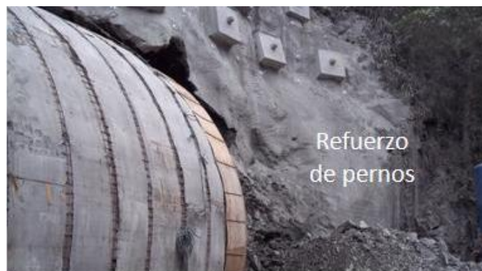
Figura 178 Colocación de pernos en el costado derecho para evitar el progreso de los desprendimientos.
