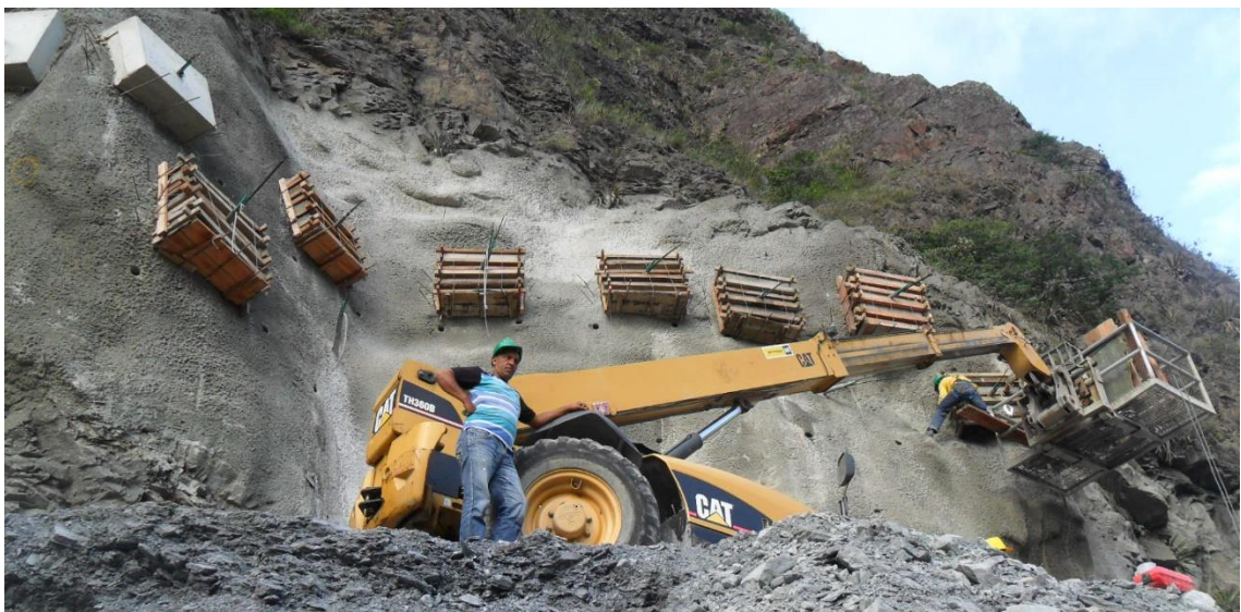
Figura 182 Conformación de rampa para instalación del soporte del talud.
