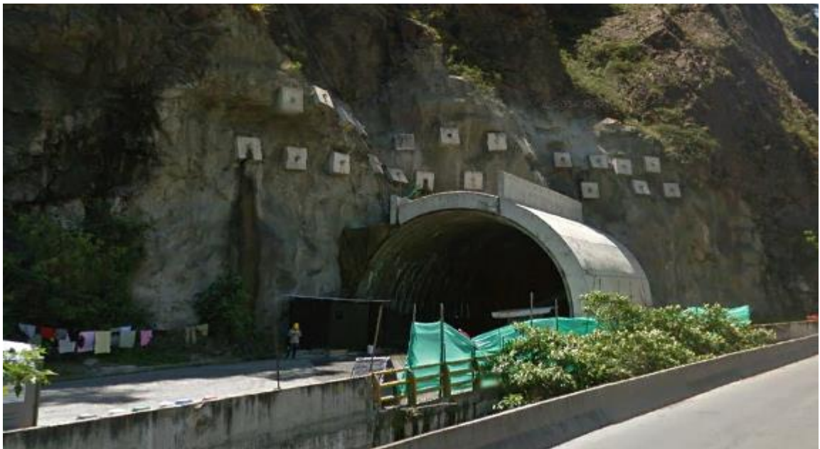
Figura 65 Tipología en "C" o sesgada del portal entrada túnel 11 izquierdo
