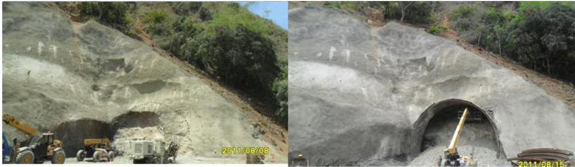
Figura 44 Proceso constructivo del portal entrada túnel 10 izquierdo (Fuente consocio ECC)
