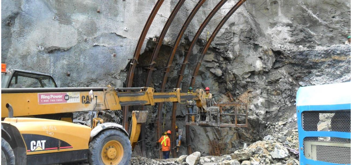
Figura 183 Inicio de excavación del portal sesgado.
