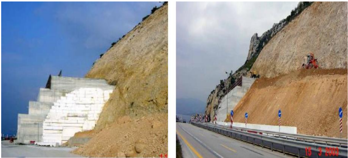
Figura 81 Construcción del portal entrada o este.
