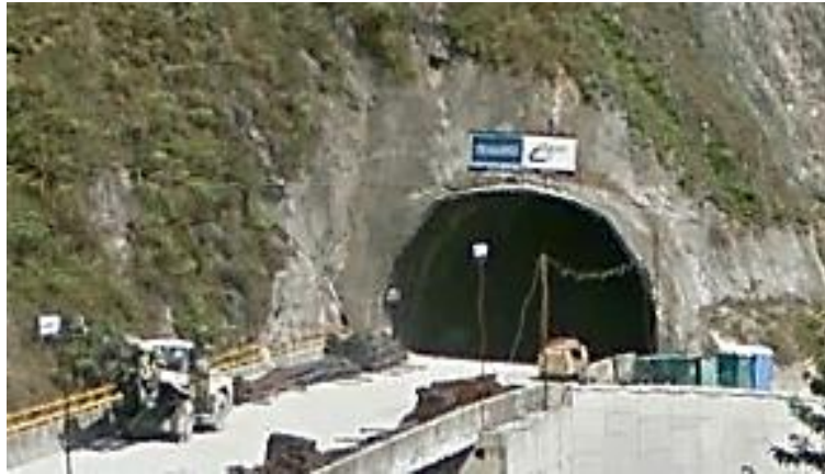
Figura 63 Resultado final del portal Bogotá túnel 6A. (Fuente Concesionaria Coviandes)
