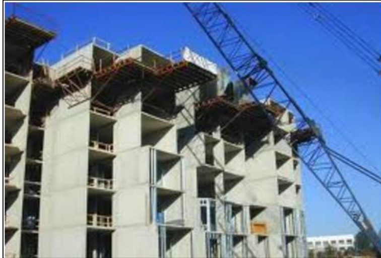
Figura 17. Industrializado (vaciado en concreto por formaleta)
