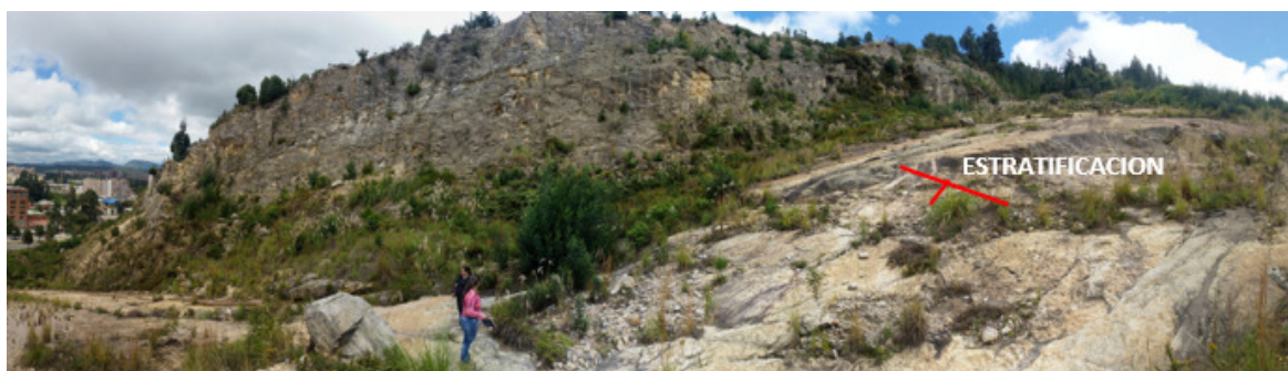
Figura 8 Cantera Servita. Área donde se diferencia claramente el plano de estratificación en el talud.
