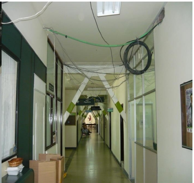
Ilustración 3-23: Disipadores Instalados
