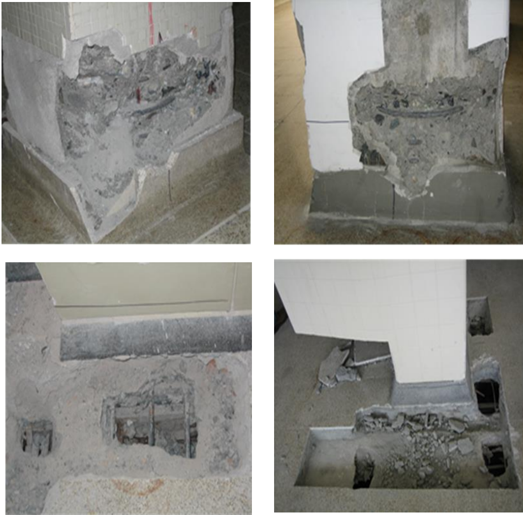
Ilustración 3-5: Regatas de Inspección columnas, Placa y viga
