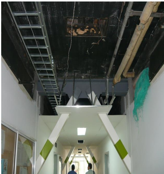
Ilustración 3-23: Disipadores Instalados
