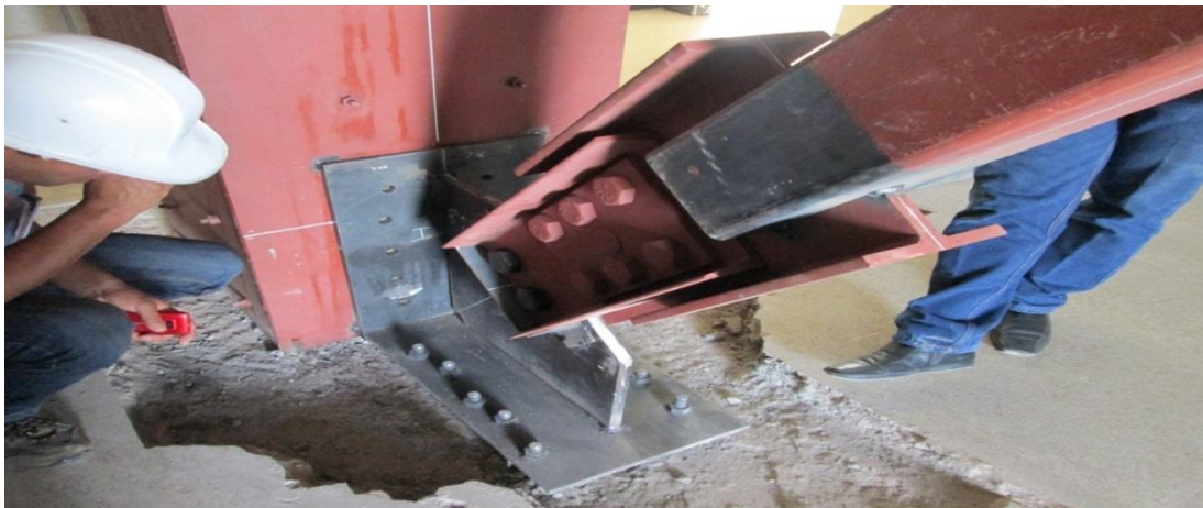
Ilustración1-5: Instalación de disipador de fricción tipo Pall
