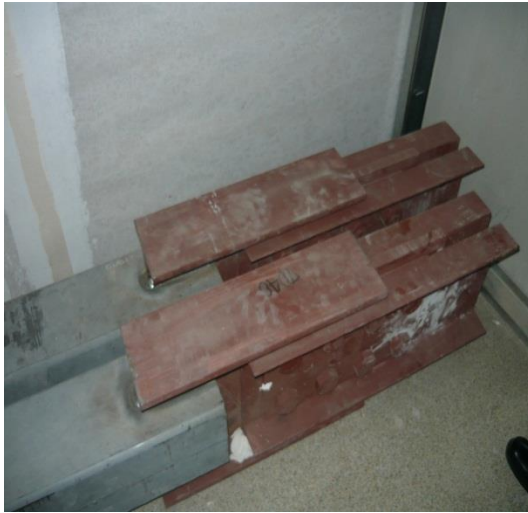
Ilustración 3-23: Disipadores Instalados
