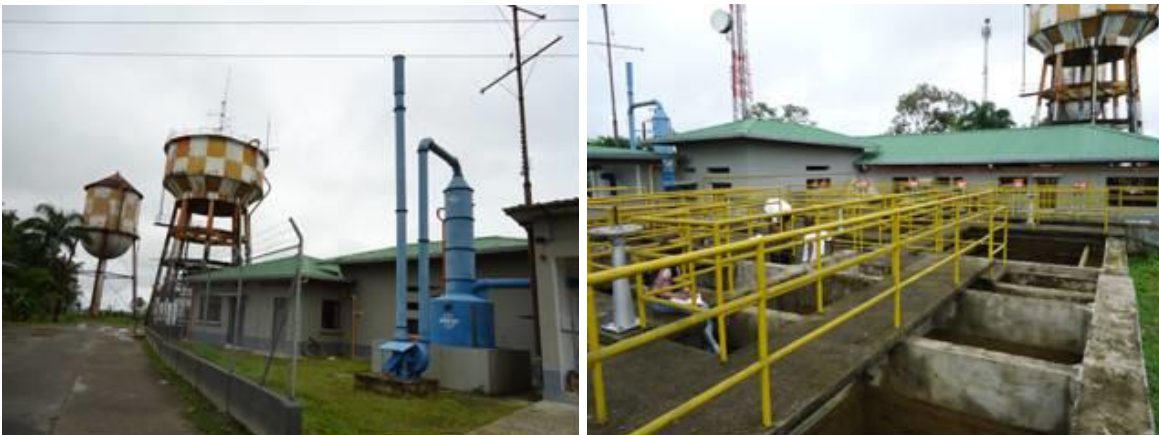
Figura 1-2. Planta de Tratamiento de La Loma
