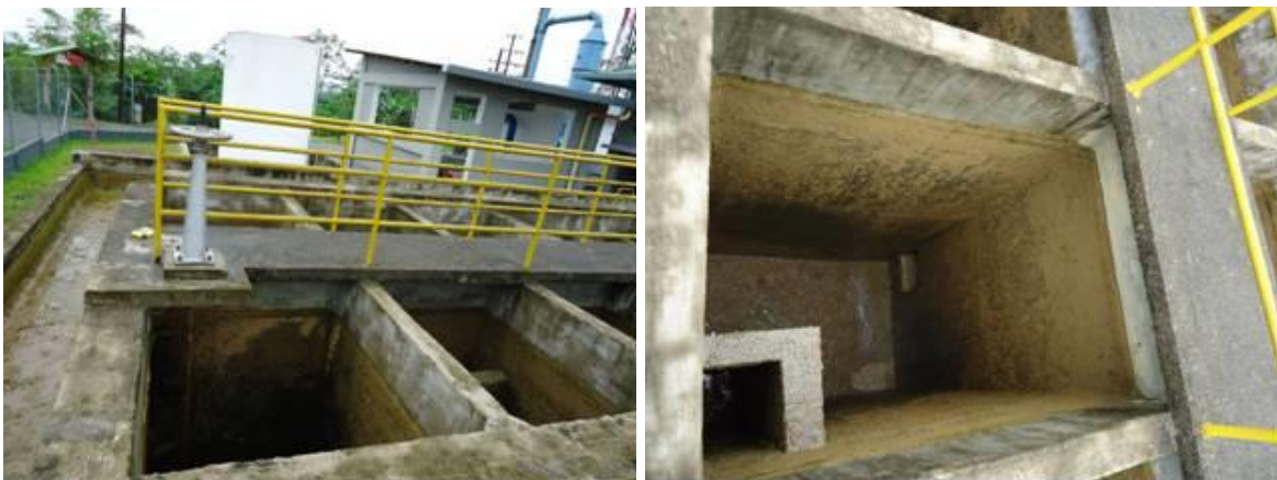
Figura 1-5. Orificios de Interconexión entre Cámaras del Floculador
