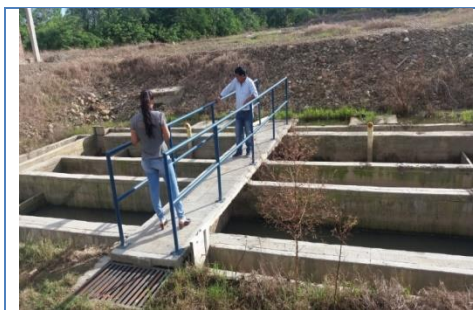
Ilustración 16. Tanque Imhoff primario
