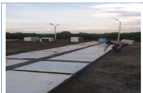
Ilustración 41. Tanque de Aireación
