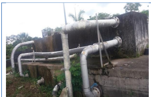
Figura 34. Filtro Aerobio
