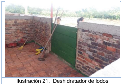
Ilustración 21. Deshidratador de lodos
