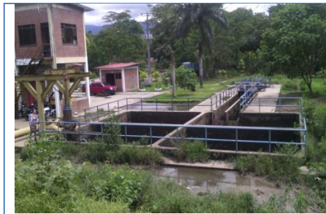
Ilustración 3. Tanque de bombeo PTAR Acacias
