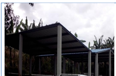
Figura 31. Lecho de secado de lodos
